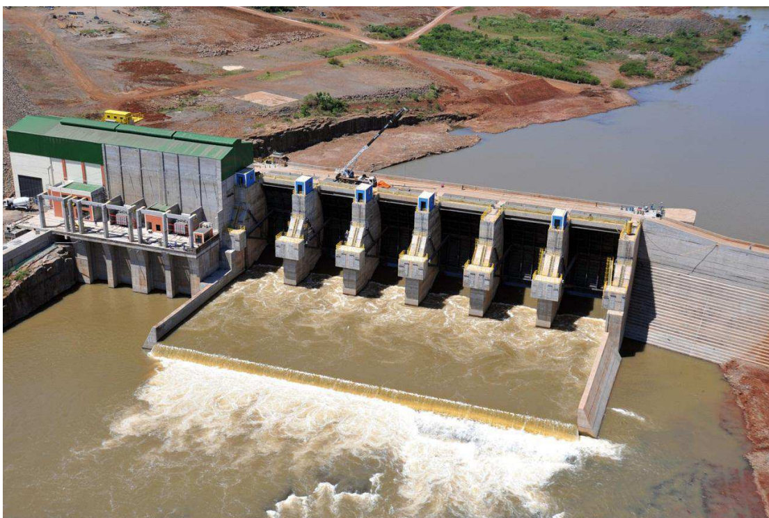
Figura 4. Fotografia do vertedouro da UHE São José em 2010
