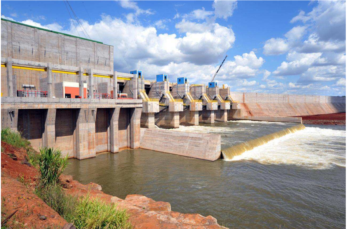
Figura 1. Foto da Jusante da barragem da UHE São José.
