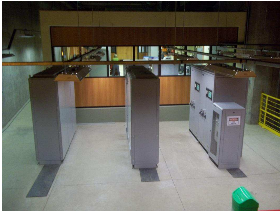
FIGURA 24 . FOTOGRAFIA DE PAINÉIS FIXADOS NA UHE SÃO JOSÉ
