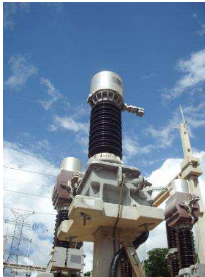
Figura 18. Foto de um TP da SE Barra da Paciência.
