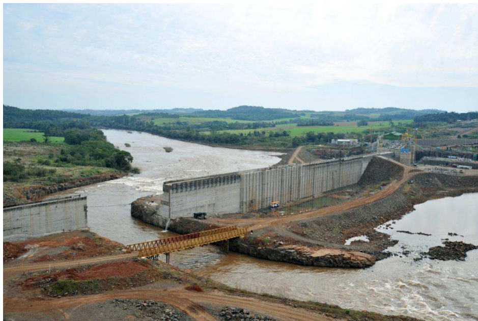
Figura 3 .Foto da Ensecadeira da UHE São Jose em 2010.
