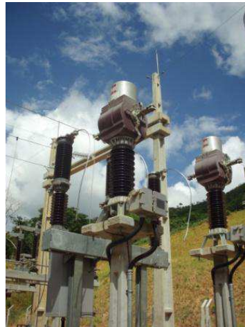
Figura 19. Fotografia do TC da SE Barra da Paciência.
