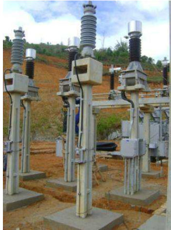
Figura 17. Foto do para-raios da SE Barra da Paciência.
