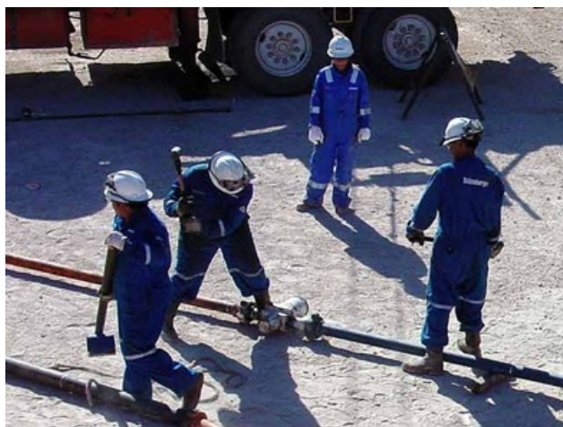
Figura 26: Montagem de linha de tratamento para teste de pressão.
