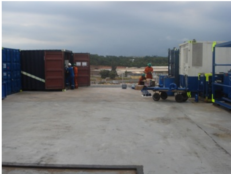
Figura 2: Pintando equipamentos e mantendo a área limpa.
