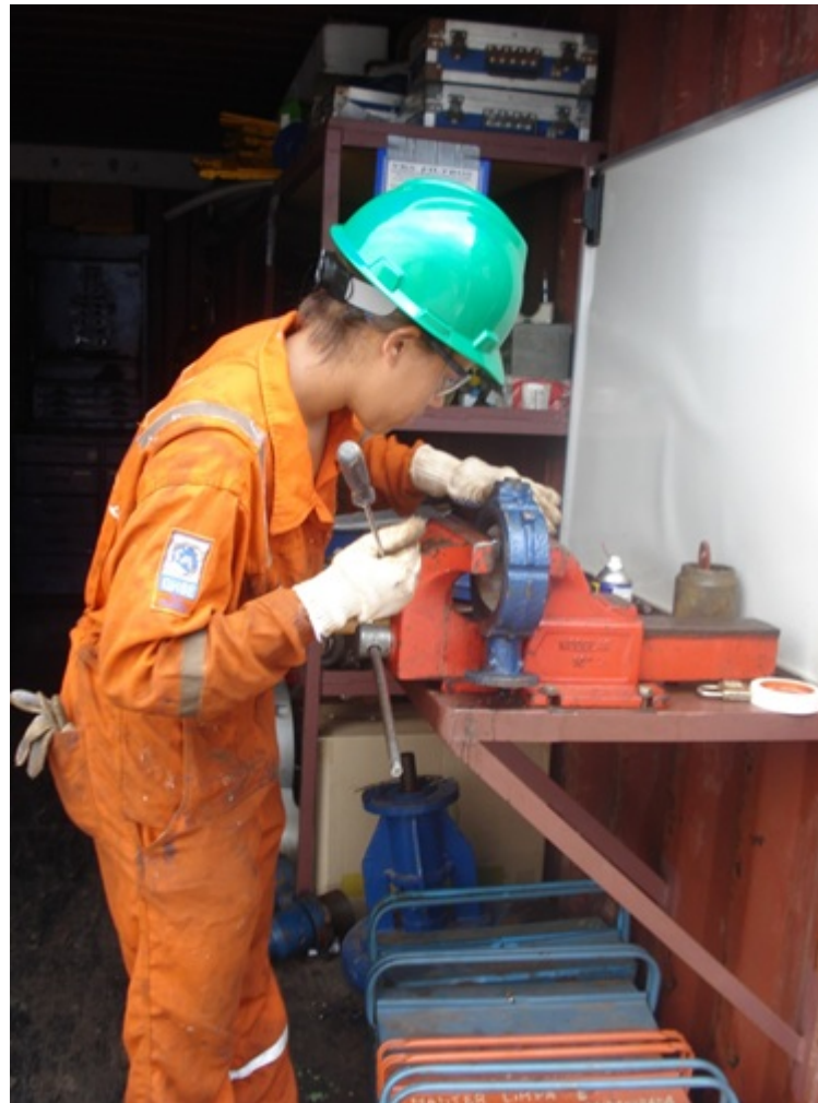
Figura 1: Realizando manutenção em válvula borboleta.
