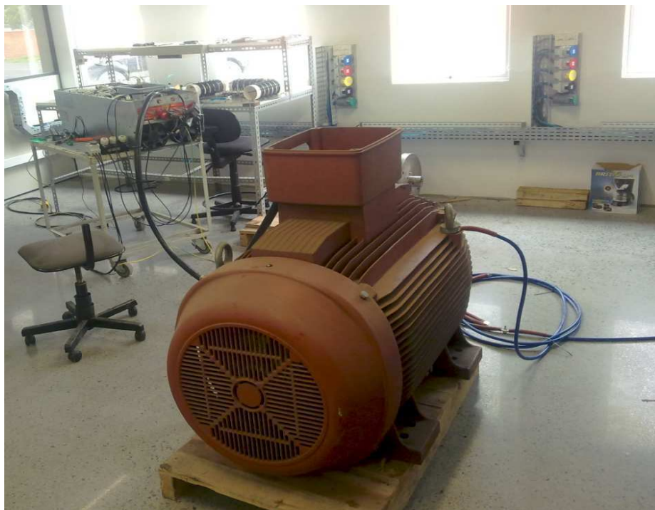
Figura 41. Motor de 500cv com cabos blindados utilizado no teste.
