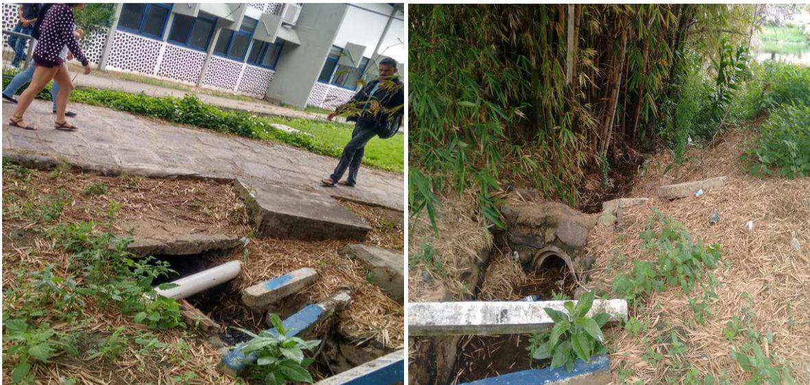
**Figura 16:** Entrada de efluente pertencente ao bloco CA na lagoa.
