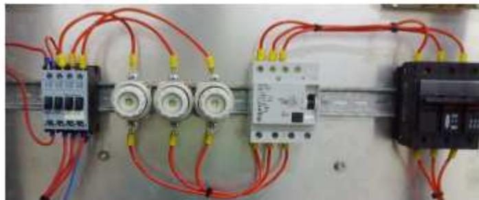
Figura 18: Circuito de proteção (Fabrício, 2010).
