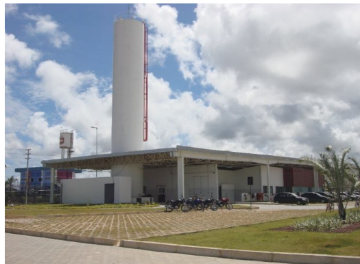
Figura 8 - Torre de água do condomínio.
