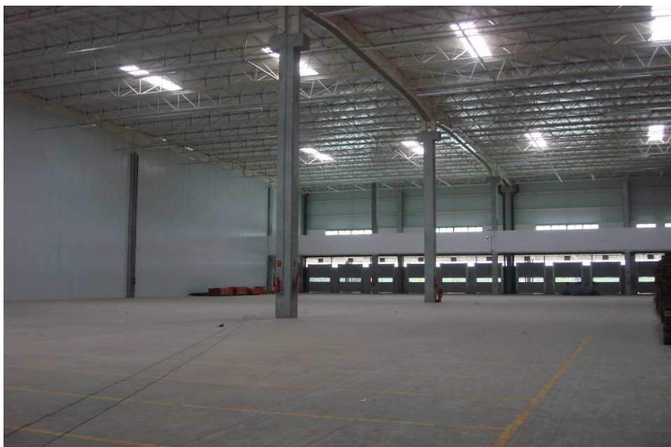
Figura 2 - Interior de um módulo do galpão.
