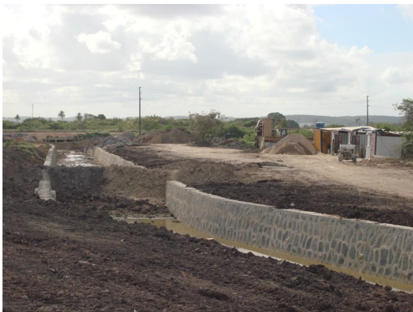
Figura 33 – Serviço de concretagem da base do canal (depois).
