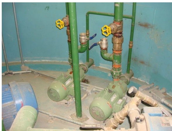
Figura 10 - Bombas centrífugas.
