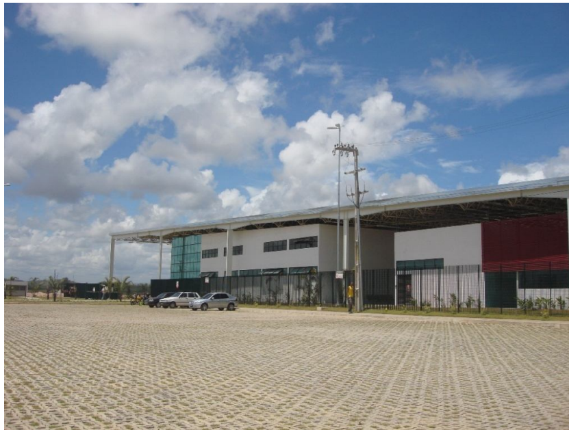
Figura 1 - Vista frontal do galpão Armazenna 02.
