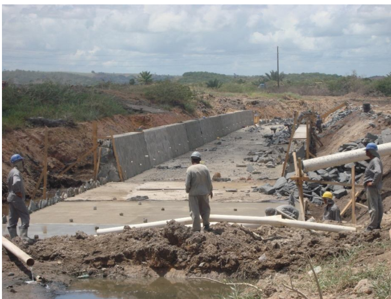
Figura 32 – Serviço de concretagem da base do canal (antes).
