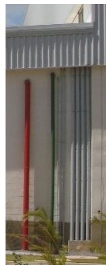
Figura 5 – Barramento dos condutores (Bus-way) em destaque.
