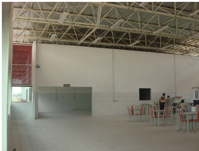
Figura 17 - Entrada da cozinha e área de refeitório.
