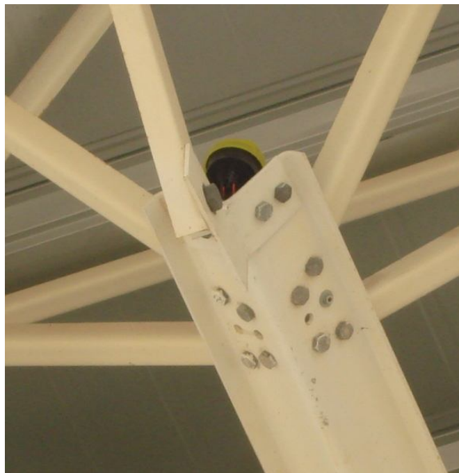
Figura 24 - Relé fotoelétrico dos postes.
