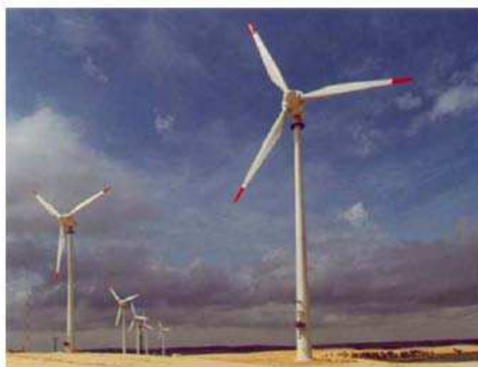
Figura 3.5: Parque Eólico Conectado à Rede
