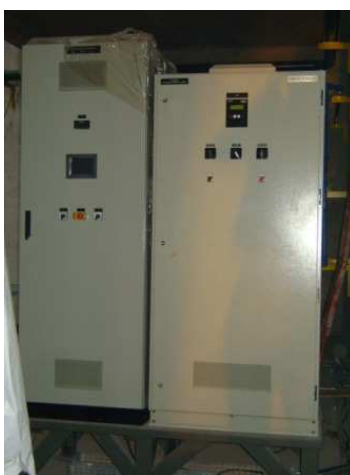
Figura 13. Foto de um painel fixado.
