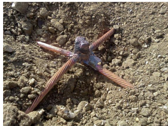
Figura 7 – Solda exotérmica
