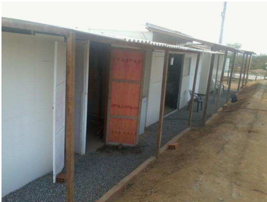
Canteiro de obras
