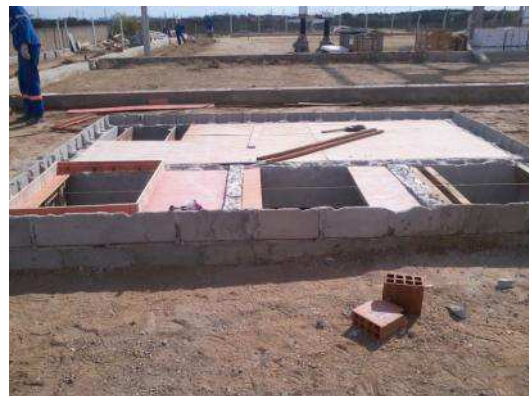
Figura 5 – Caixa separadora de óleo.
