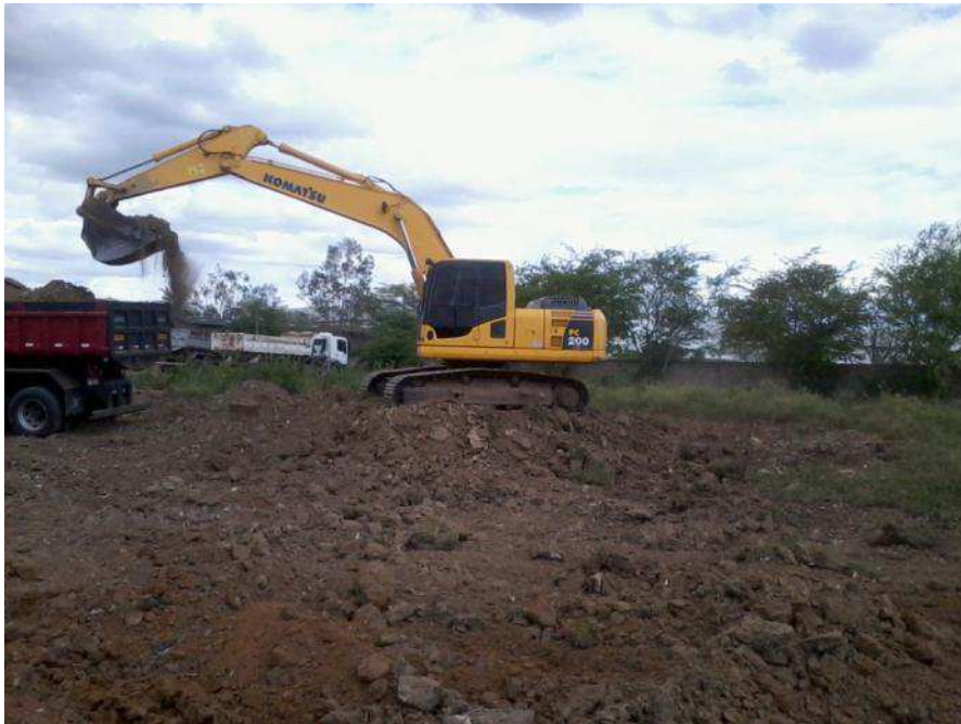
Limpeza e retirada da vegetação do terreno.
