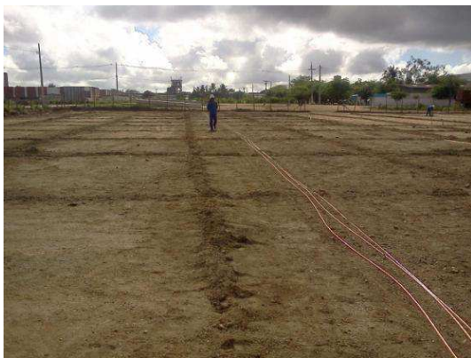
Figura 6 – Malha de terra.
