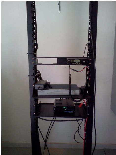
Figura 13: Bancada de comunicação e inversor.
