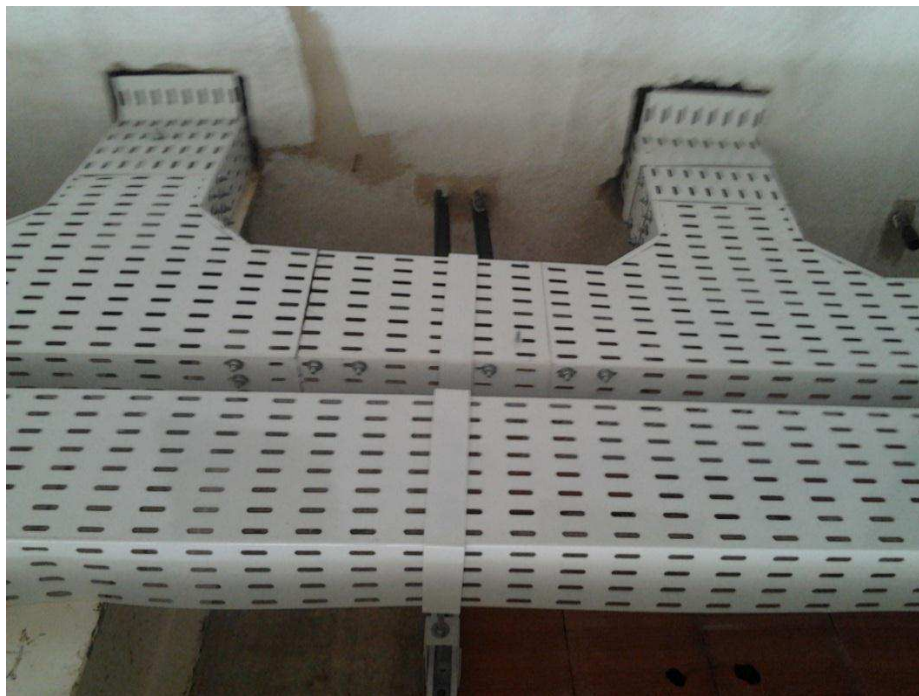
Figura 16 - Eletrocalhas utilizadas.
