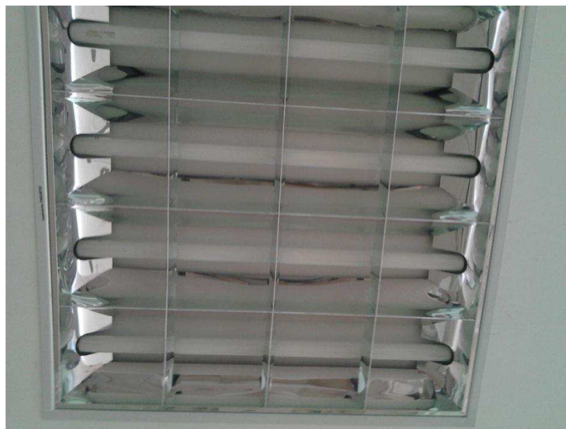
Figura 4 - luminária para 4 lâmpadas fluorescentes de 16W com aletas
