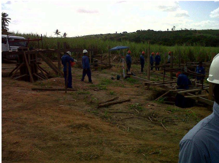
Figura 16: Concretagem da estrutura 6/1 da LT de 230 kV Goianinha – Mussuré II – Santa Rita II.
