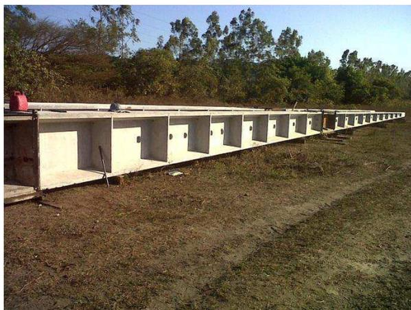
Figura 29: Detalhe do poste duplo “T” da estrutura 1/1.
