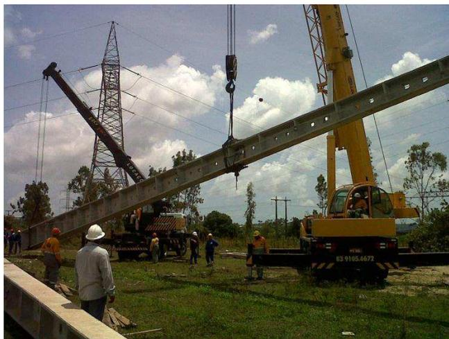
Figura 30: Içamento do poste duplo “T” da estrutura 1/1.
