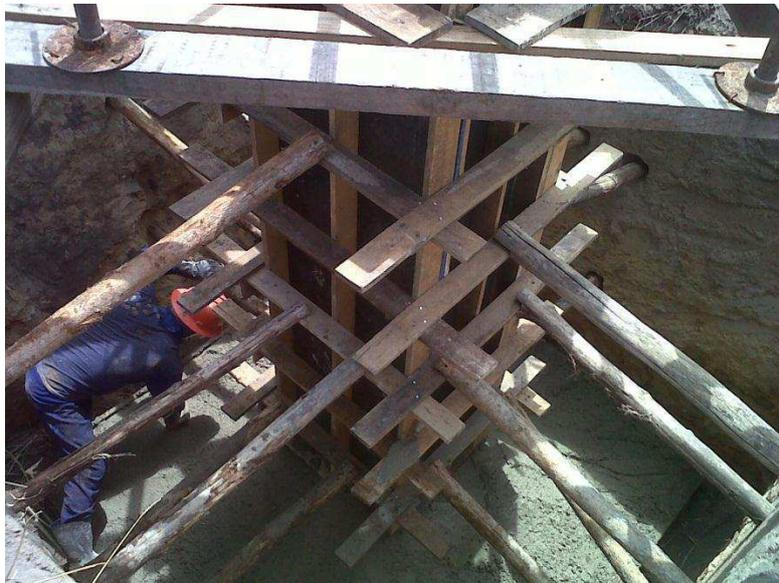
Figura 24: Detalhe da aplicação e moldagem do concreto na fundação da estrutura 6/1.
