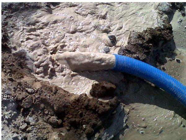
Figura 21: Mangueira da bomba d'água auxiliando na remoção da água do interior da cava.
