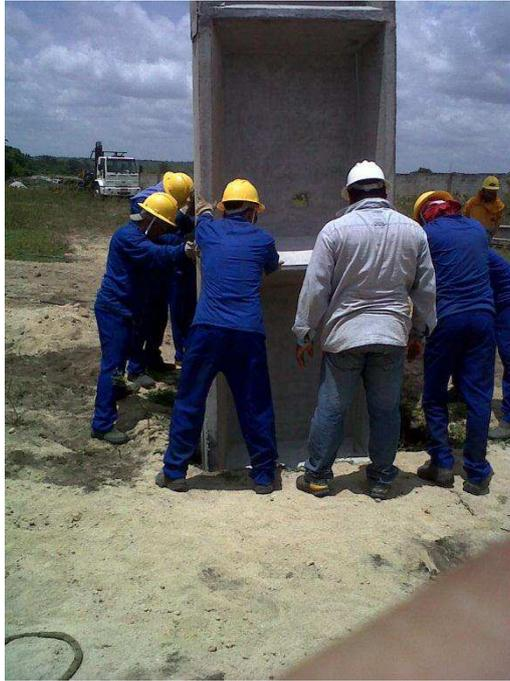
Figura 31: Implantação do poste da estrutura 1/1 com auxílio dos montadores.
