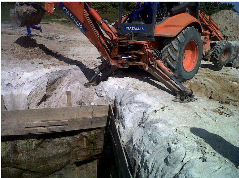
Figura 19: Retroscavadeira realizando escavações da estrutura 1/2 da LT de 230 kV Goianinha – Mussuré II – Santa Rita II.
