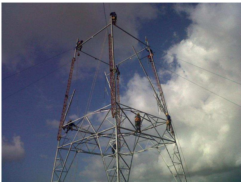
Figura 26: Detalhe da montagem da extensão para a base da estrutura 10/1.
