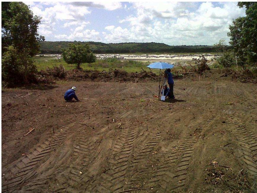
Figura 15: Locação de cavas da estrutura 2/2 da LT de 230 kV Goianinha – Mussuré II – Santa Rita II.
