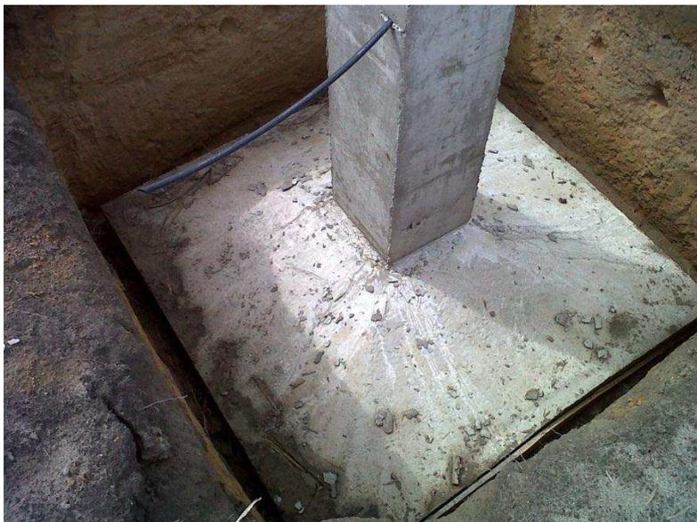
Figura 25: Detalhe da sapata após a remoção dos moldes da estrutura 3/2.
