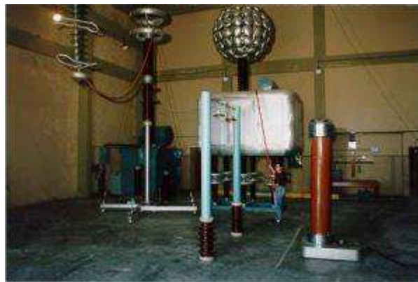
Figura 1 - Salão de Alta Tensão
