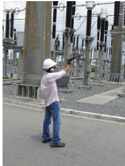
Figura 26. Medição utilizando a pistola de ultrassom.
