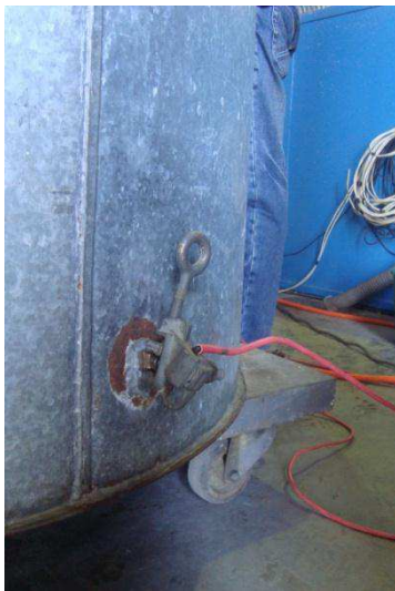
Figura 33. Detalhe da conexão da parte externa do tanque com a terra.
