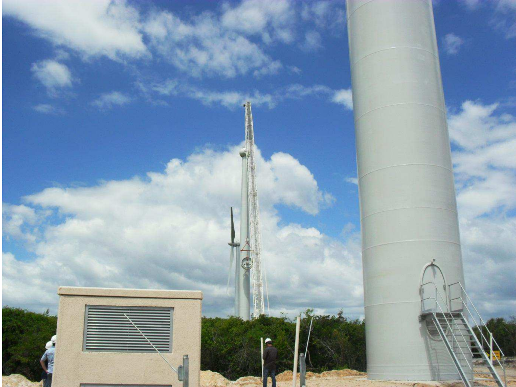
Figura 11. Central Eólica Quixaba em construção.
