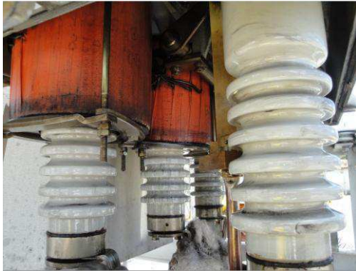
Figura 26 - Limpeza da parte interior do religador
