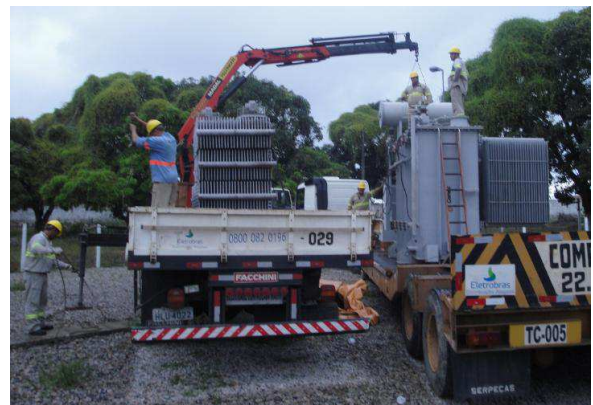
Figura 37 - Desmontagem tanque de expansão
