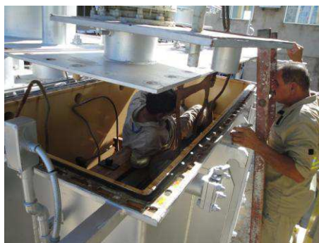
Figura 6 - retirada da tampa superior.
