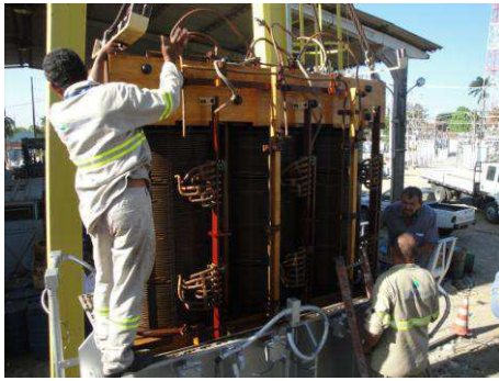
Figura 8 - Içamento do núcleo
