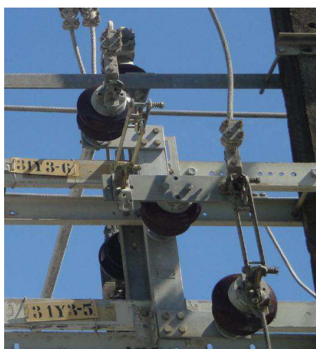
Figura 20 - Chave bypass aberta, chave do religador fechada.
