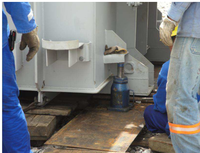
Figura 30 - Macaco hidráulico usado para erguer o transformador
