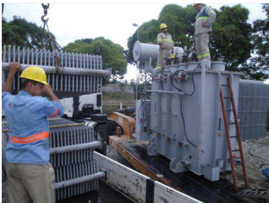
Figura 36 - Desmontagem dos radiadores
