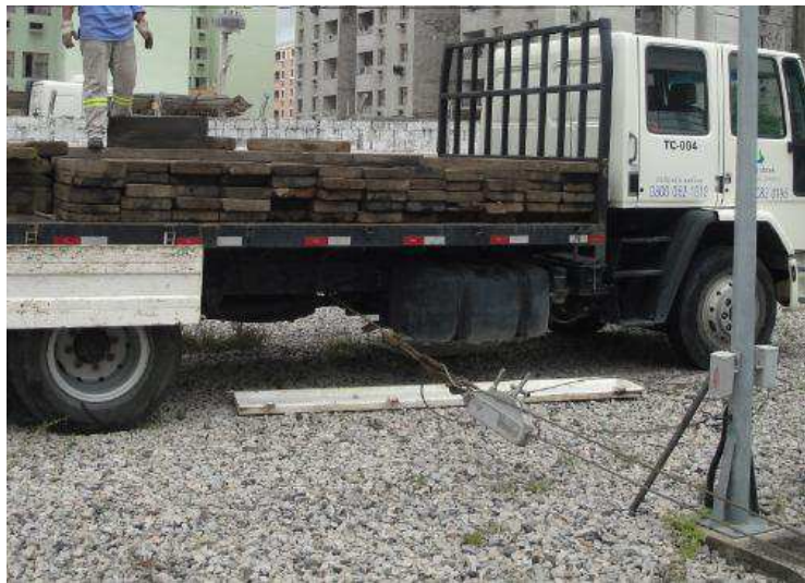
Figura 32 - Uso da tritor para puxar o transformador
