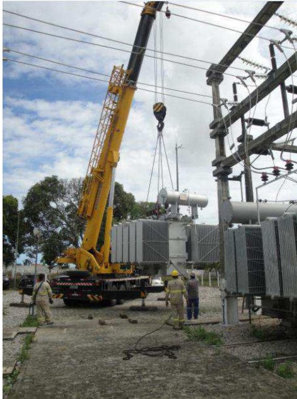
Figura 34- Movimentação do transformador com guincho
