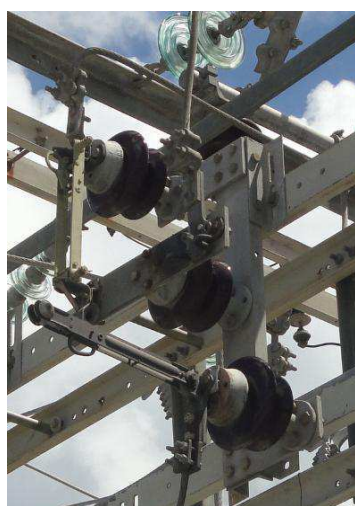
Figura 21 - Chave bypass fechada, chave do religador aberta.
