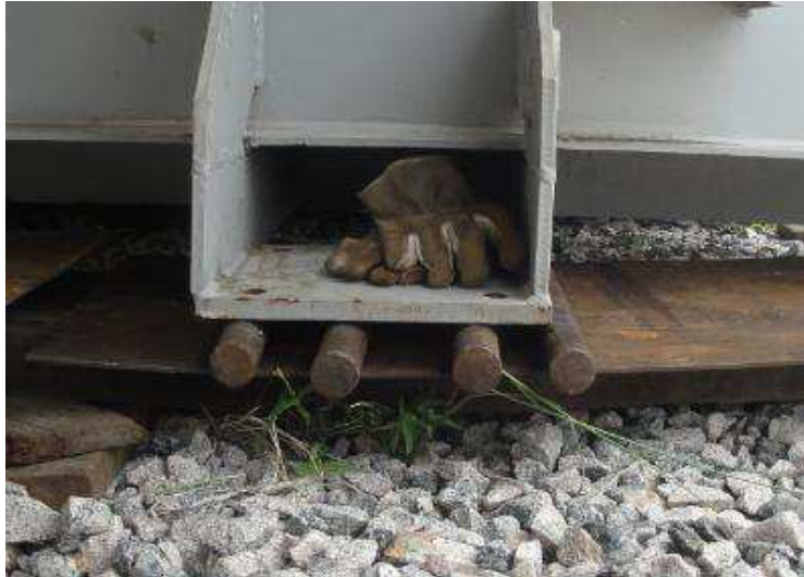
Figura 31 - Uso de roletes para movimentar o transformador
