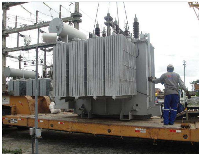
Figura 35 - Transformador sendo colocado na carreta para transporte
