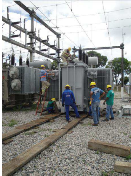
Figura 29 - Construção de trilho de madeira para locomoção do transformador
