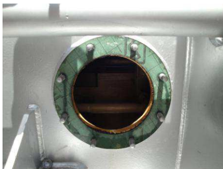
Figura 4 - Tampa de inspeção aberta
