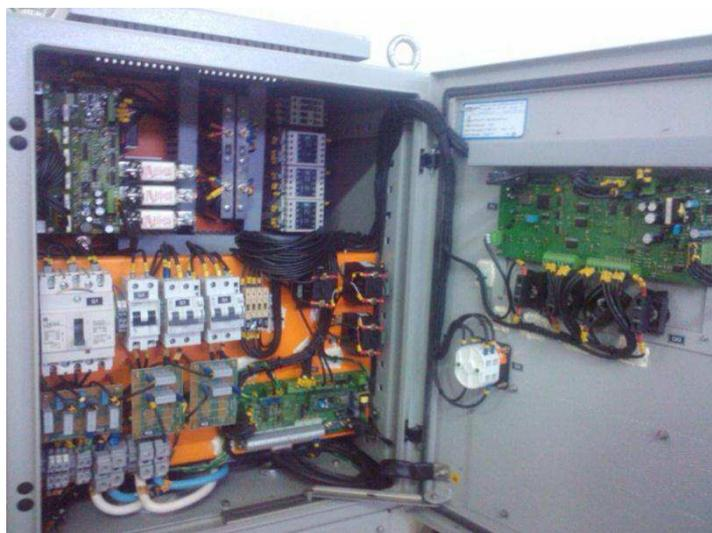
Figura 4.15. Detalhe interno do carregador.
