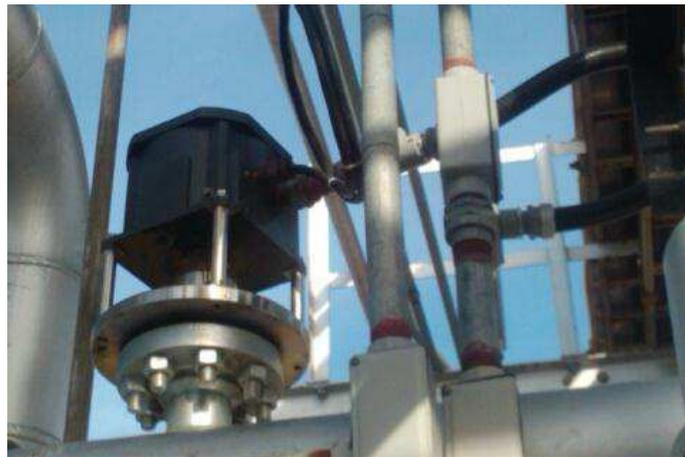
Figura 4.17. Fotografia do sensor de vazão FQI.
