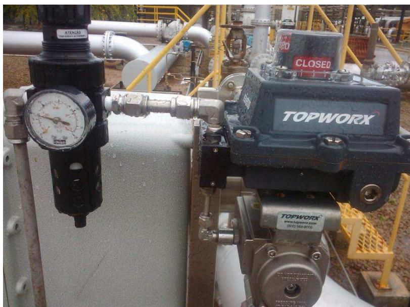
Figura 4.21. Fotografia da válvula pneumática do TOG *on-line*.
