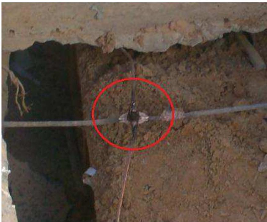
Figura 4.6. Fotografia mostrando detalhe de solda exotérmica no aterramento.
