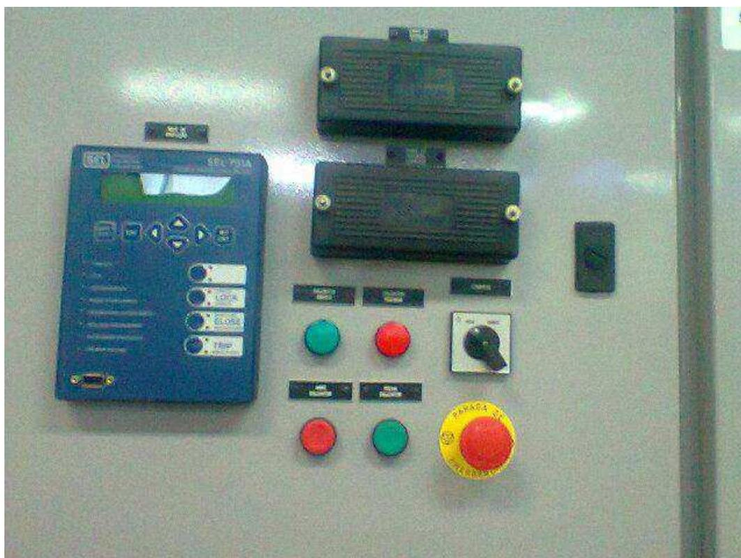
Figura 4.10. Detalhe relé de proteção PN-401.15.
