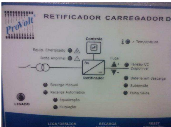
Figura 4.14. Detalhe do painel de comando carregador de baterias.
