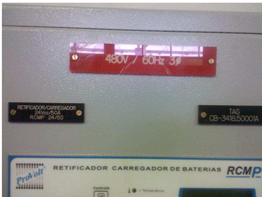
Figura 4.13. Fotografia das etiquetas identificadoras do carregador.
