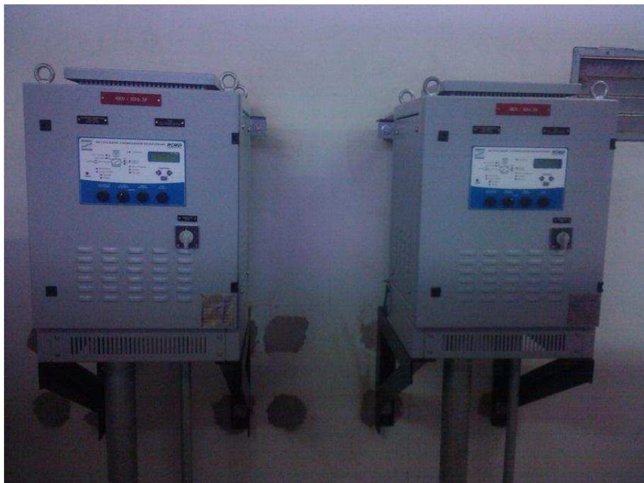
Figura 4.12. Fotografia mostrando os carregadores de baterias.
