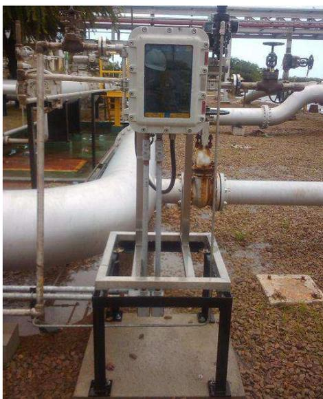
Figura 4.20. Fotografia do equipamento TOG *on-line* instalado.
