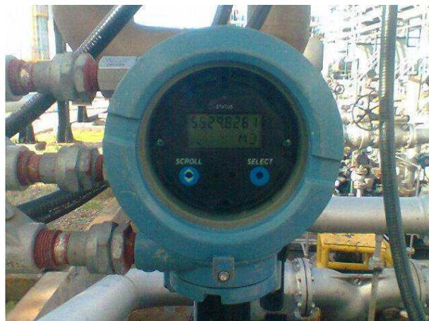
Figura 4.18. Fotografia do transmissor do sensor FQI.
