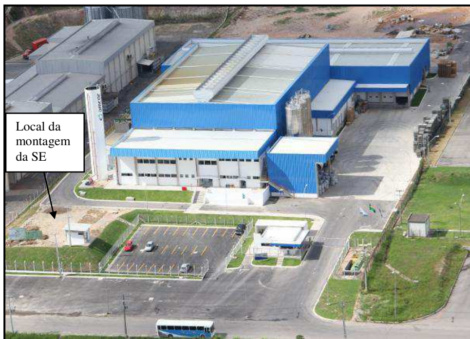
Figura 1- AMCOR Ltda., local onde foi construída a subestação
