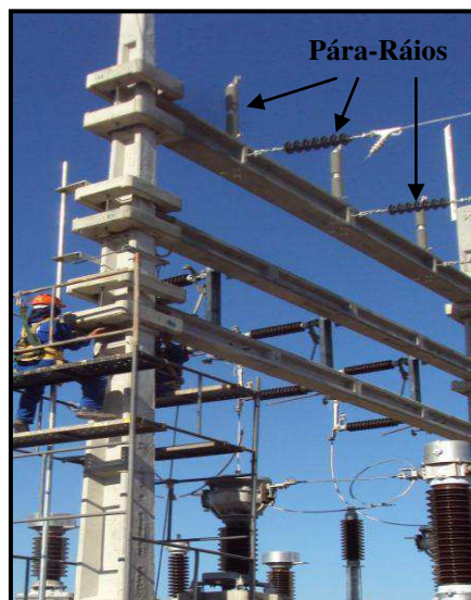
Figura 11- Pára-Raios da SE – AMCOR
