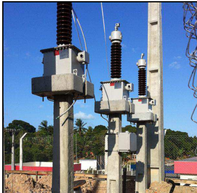
Figura 6 - TP's de proteção
