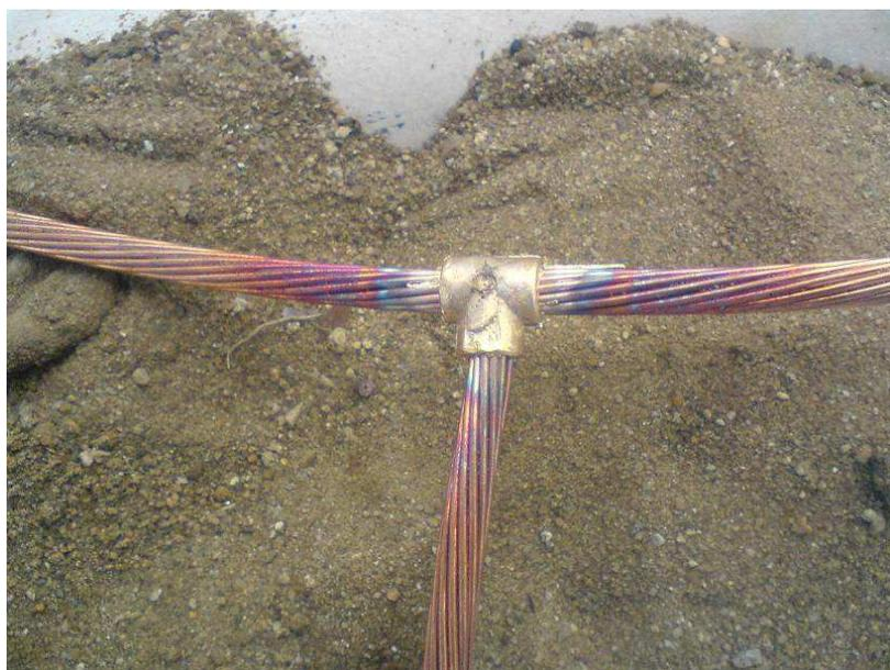
Figura 15: Detalhe da solda exotérmica da malha de aterramento.
