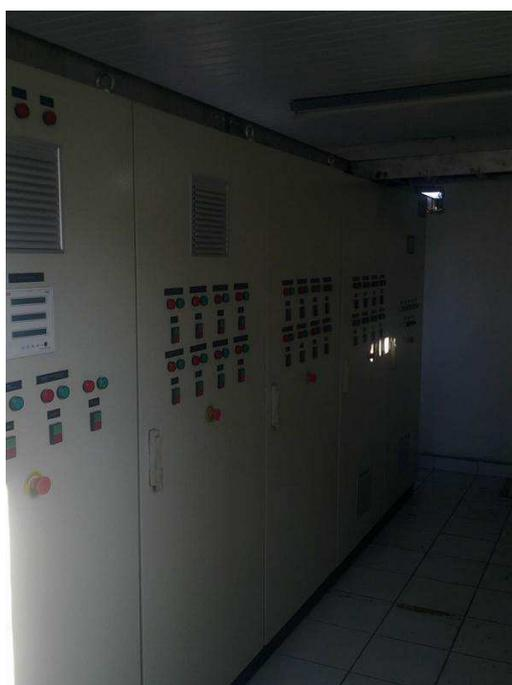
Figura 17: Painel de comando geral da Máquina de triturar baterias.
