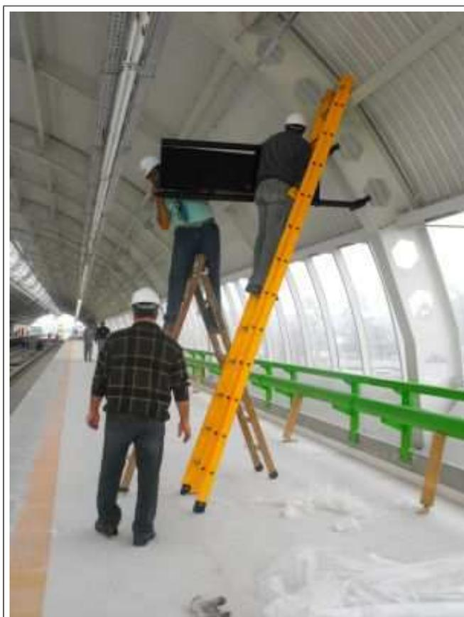
Figura 3.1: Procedimento de instalação do sistema de sincronismo nas estações
