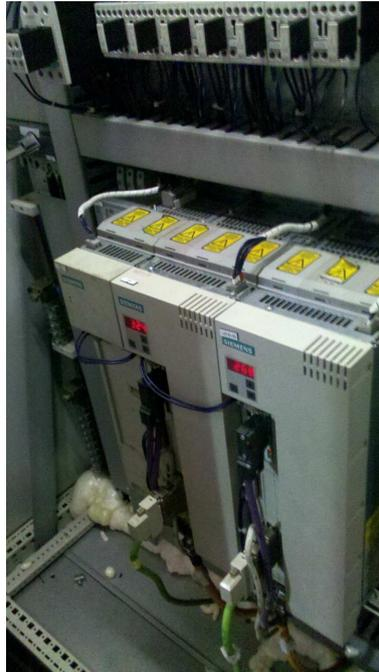
Figura 36: Inversor de frequência masterdrive, instalado na fábrica da Coca-Cola.
