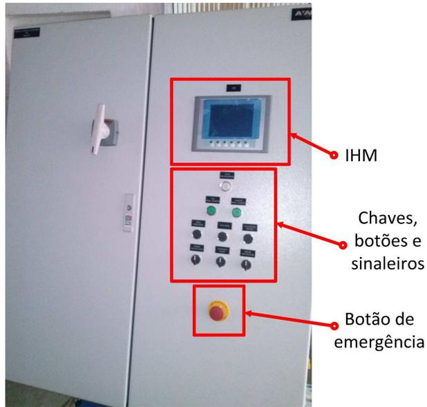
Figura 19: Visão externa do painel da TBS.
