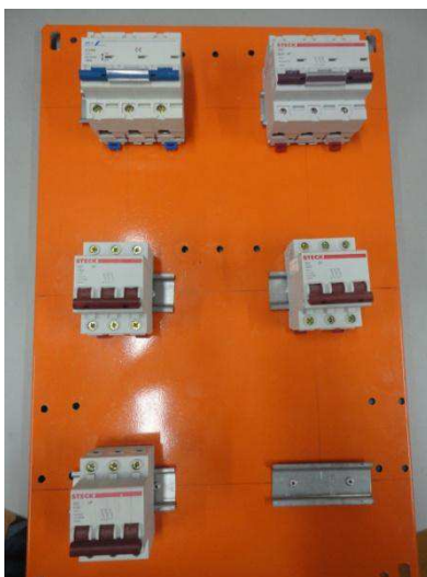
Figura 6. Montagem do quadro de medição.
