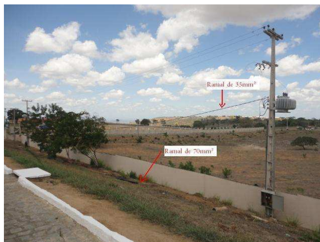
Figura 12. Ramais em funcionamento.
