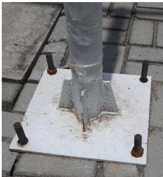
Figura 1. Base do poste parafusado mas faltando porcas.
