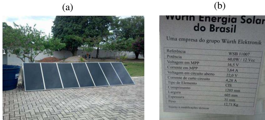
Figura 15. (a) Módulos fotovoltaicos do tipo amorfo utilizado para geração de energia; (b) Parâmetros do módulo fotovoltaico utilizado. Fonte: Arquivo pessoal.
