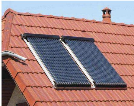
Figura 12. Coletores solares térmicos para o aquecimento de água instalados no telhado de uma residência. Fonte: [www.merkasol.com](http://www.merkasol.com).
