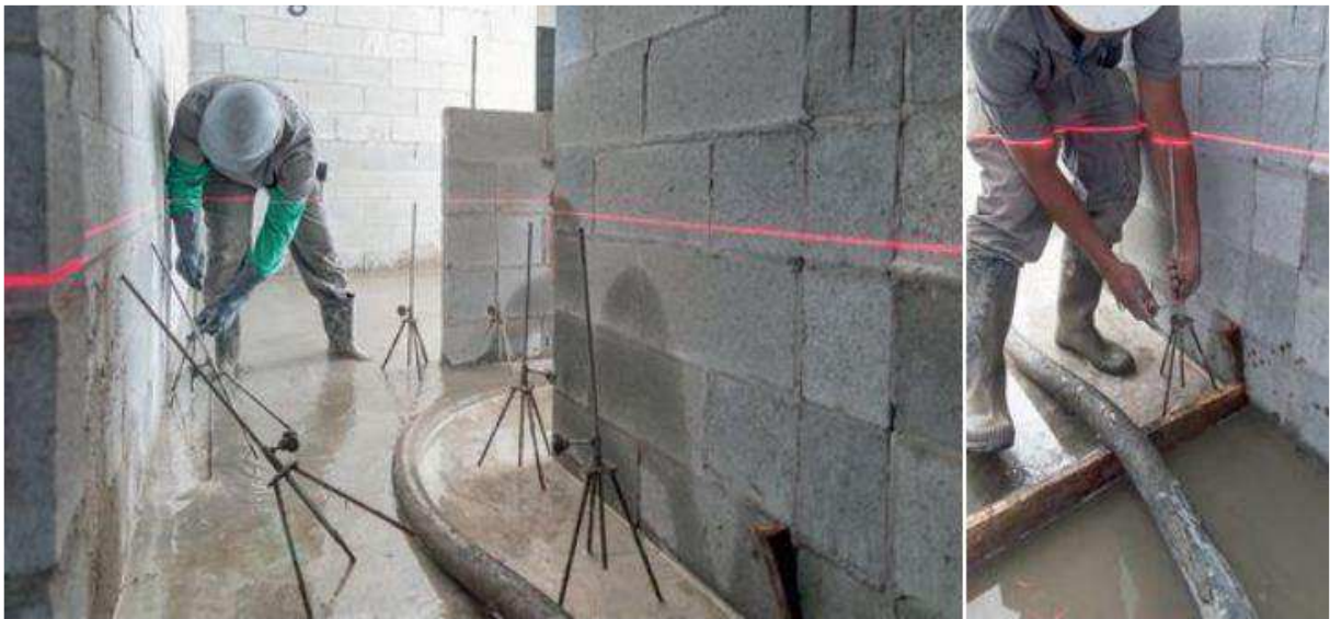
Figura 2 - Posicionamento das niveletas
