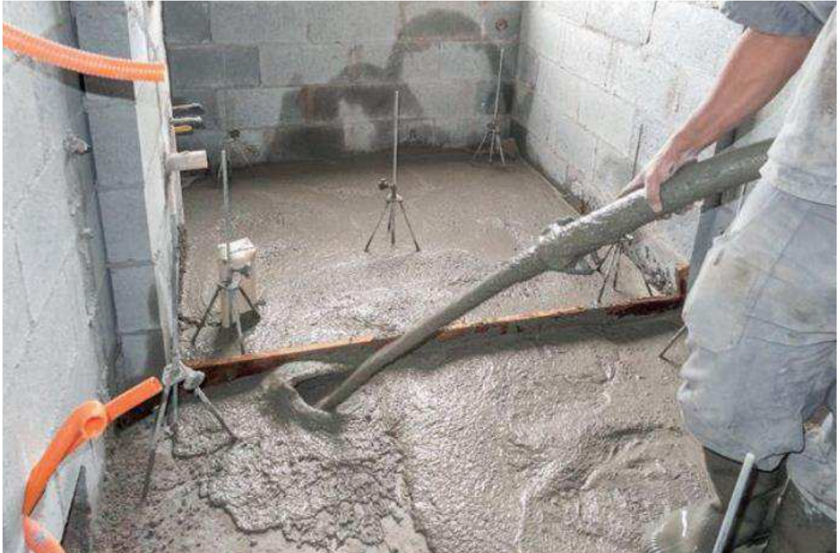
Figura 3 - Lançamento da argamassa autonivelante
