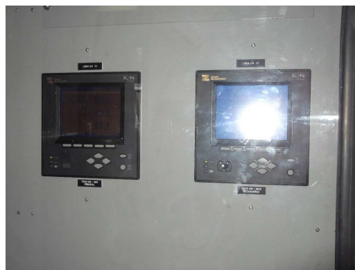
Figura 26: Multimetrores localizados na cabana de Medição e Faturamento.
