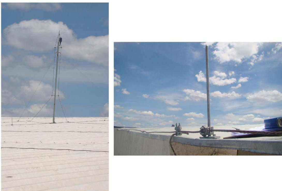
Figura 15: Captação pelo método Franklin.
