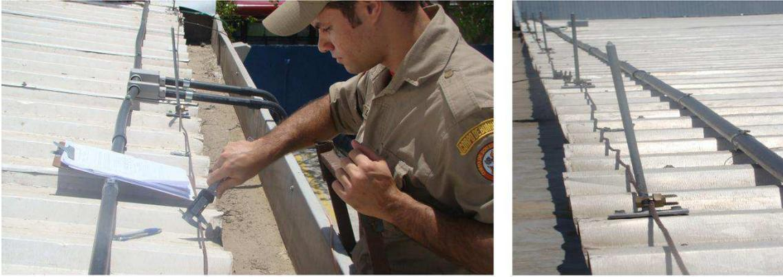
Figura 16: Malha de captação circundando o perímetro da edificação.
