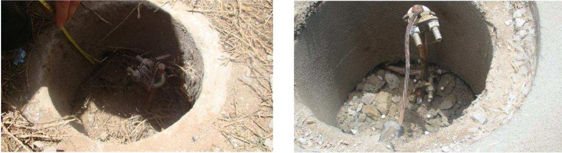
Figura 18: Caixa de inspeção e aterramento.
