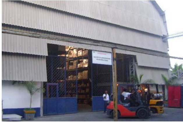
Figura 35. Foto do novo galpão do novo Almoarifado da UN-01. Fonte: Imagem própria, Brasil, 2012.
