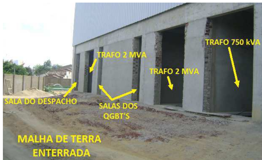
Figura 34. Imagem do abrigo da SE-10 com malha de terra coberta na UN-01. Fonte: Imagem própria, Brasil, 2012.
