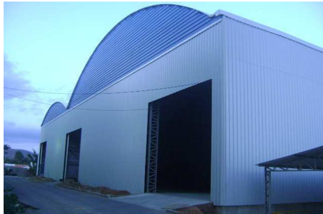
Figura 36. Foto do novo galpão para a Seção-07 da formação de baterias. Fonte: Imagem própria, Brasil, 2012.
