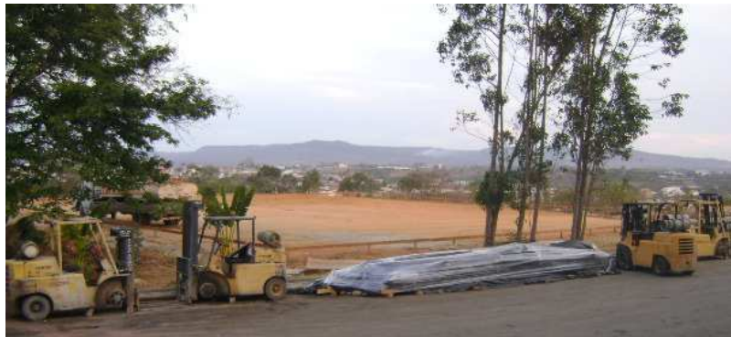
Figura 25. Vista da área onde será construído o novo vestiário e lavanderia da UN-05. Fonte: Imagem própria, Brasil, 2012.
