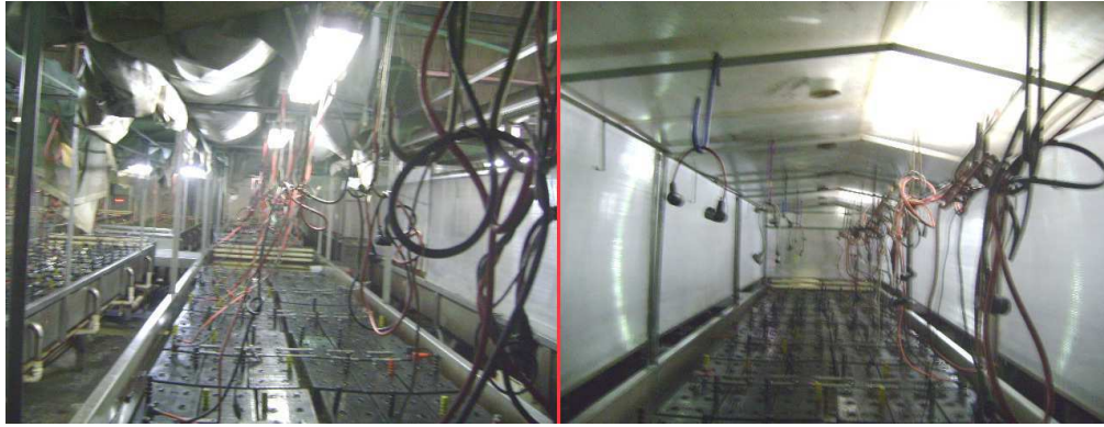
Figura 30. Fotos de relocação elétrica para adaptação em Bancos de Formação. Fonte: Imagem própria, Brasil, 2012.
