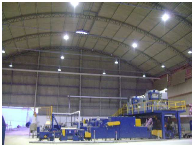
Figura 5. Foto da iluminação a LED no novo galpão do empastamento da UN-08. Fonte: Imagem própria, Brasil, 2012.
