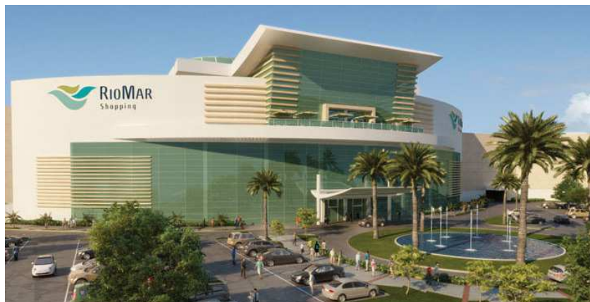
Figura 44. Vista da fachada do Shopping RioMar em Recife. Fonte: Google imagens, Brasil, 2012.
