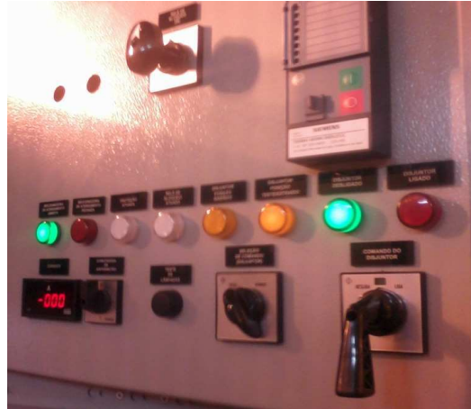
Figura 43. Foto destacando a parte de comando local de um painel Siemens-Simoprime. Fonte: Imagem própria, Brasil, 2012.
