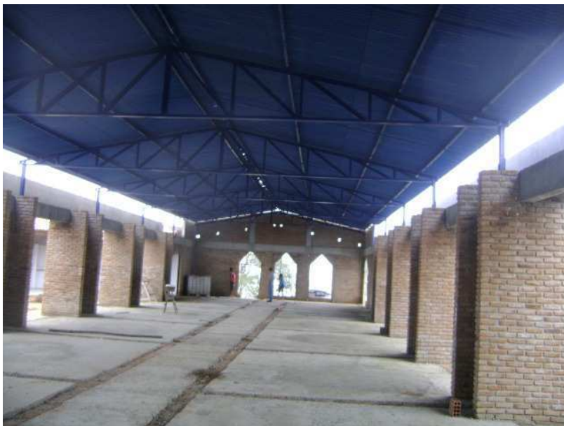
Figura 23. Foto com detalhe da cobertura relocada e piso a ser feito com concreto armado. Fonte: Imagem própria, Brasil, 2012.
