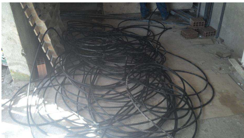
Figura 13 - Retirada do cabo de aço dos elevadores
