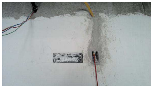
Figura 17 - Ponto para de Central de ar controlada
