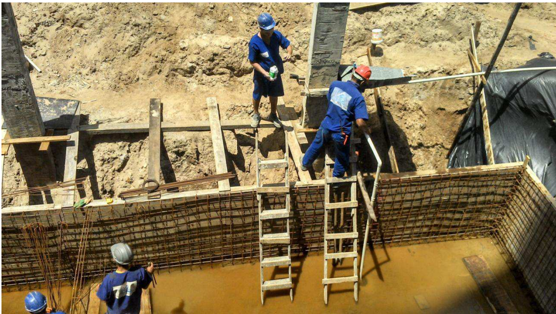
Figura 12 - Instalação da bomba d'água para secagem da cisterna
