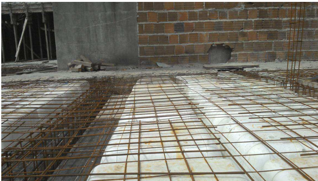
Figura 6 - Laje a ser concretada
