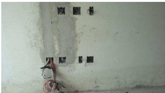
Figura 16 - Mudança nos pontos de antena e tv para um HTPC
