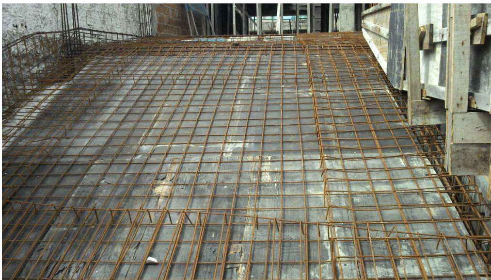
Figura 7 - Rampa a ser concretada
