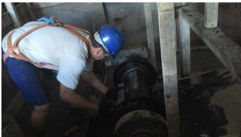
Figura 15 - Troca do Cabo de Aço dos Elevadores
