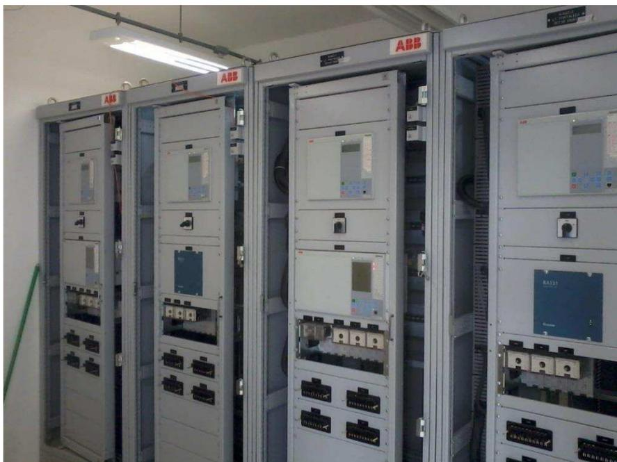
Figura 8 – Painéis do relé RED 670 na subestação de Aquiraz.
