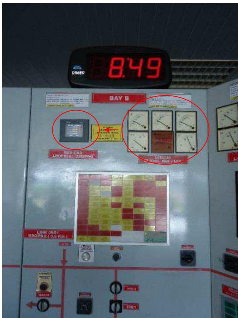
Figura 16 – Medidores analógicos em painel
