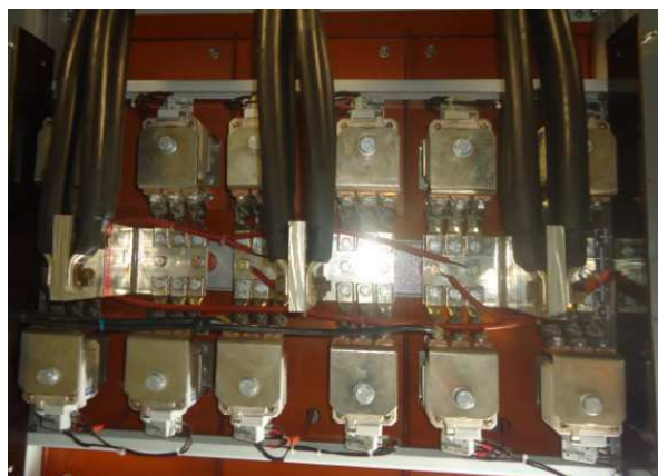
Figura 3.28 Exemplo de ponte de tiristores.
