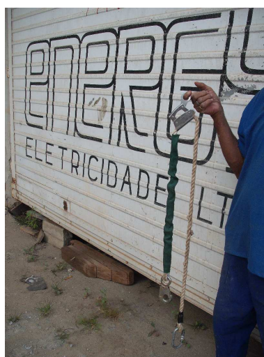
Figura 2.23: Trava-quedas que é ligada à linha de vida.
