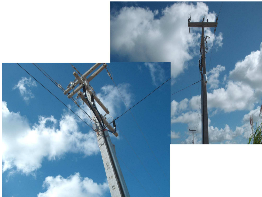
Figura 2.13: Detalhe da estrutura das cruzetas já fixadas nos postes.
