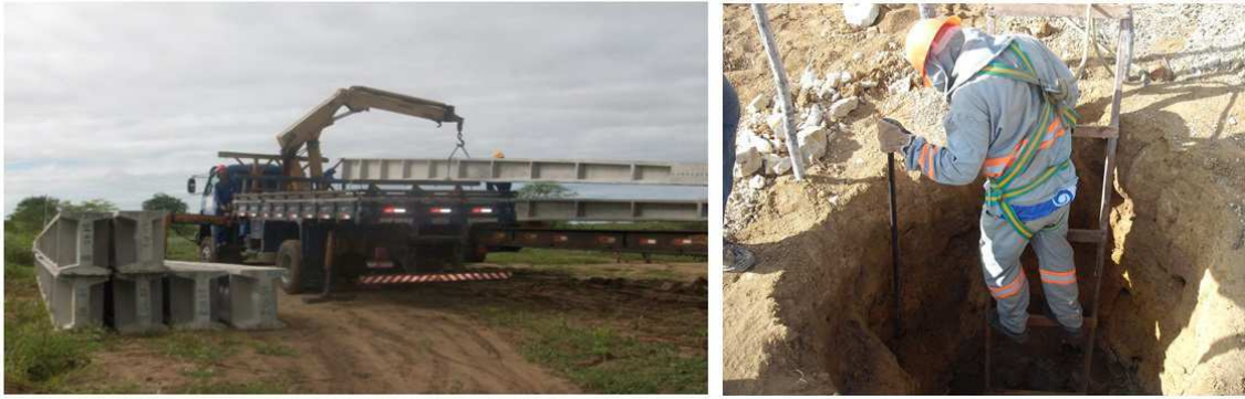
Figura 3.4: Readequação das escavações e distribuição dos postes
