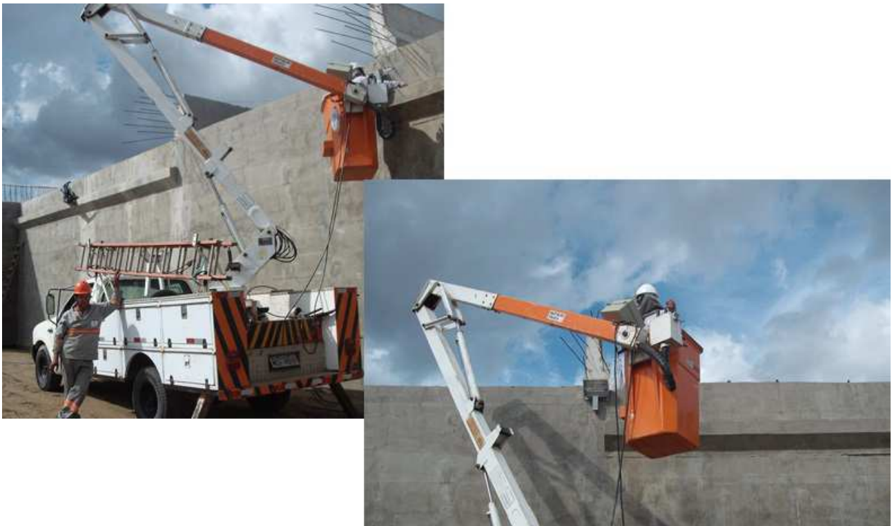
Figura 3.2: Execução do serviço de instalações de refletores
