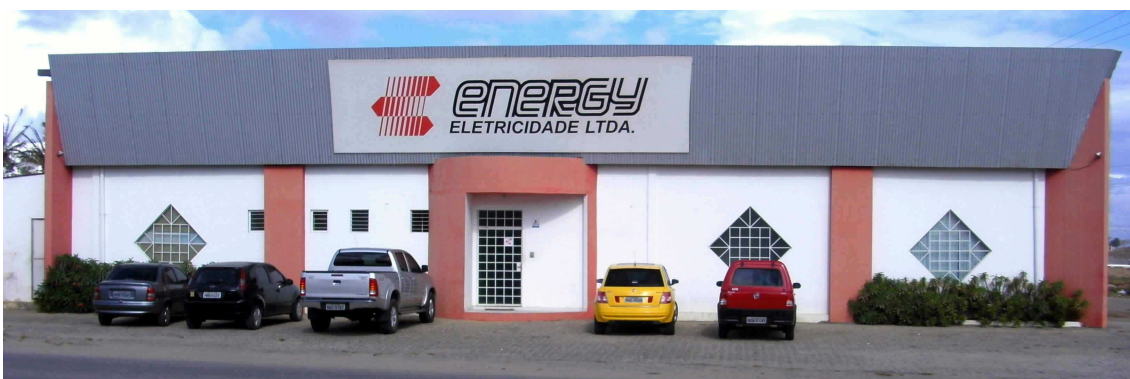
Figura 1.2: Vista da Sede Comercial da Empresa Energy Eletricidade LTDA.
