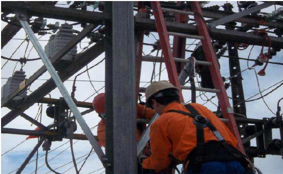
Figura 33: Troca de cantoneiras depreciadas em CGU
