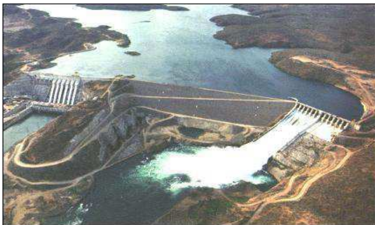
Figura 3: Usina hidrelétrica de Xingó
