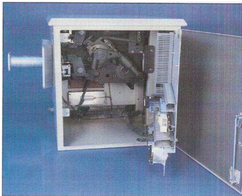
Figura 24: Mecanismo operacional do disjuntor ABB LTB 145
