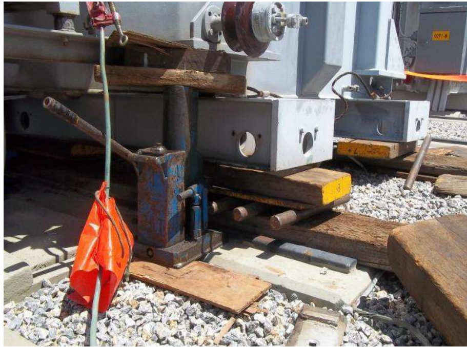
Figura 37: Utilização de roletes para deslocamento de transformador em CGU
