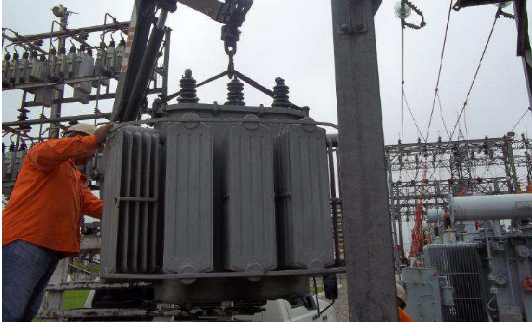
Figura 32: Permuta do transformador de serviços auxiliares de CGU
