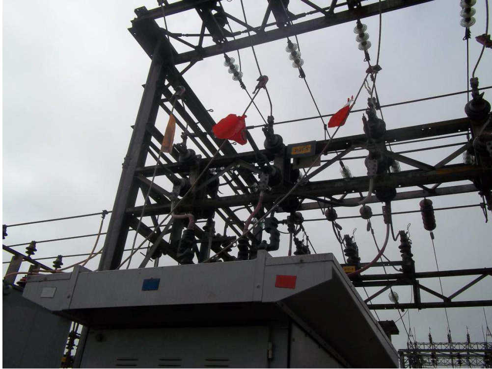
Figura 31: Aterramento dos alimentadores em CGU
