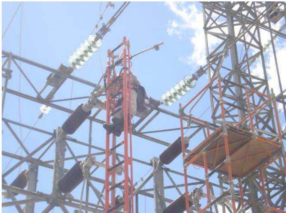
Figura 14: Eletricista ao potencial utilizando a skyladder
