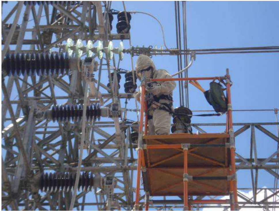
Figura 13: Eletricista ao potencial utilizando um andaime
