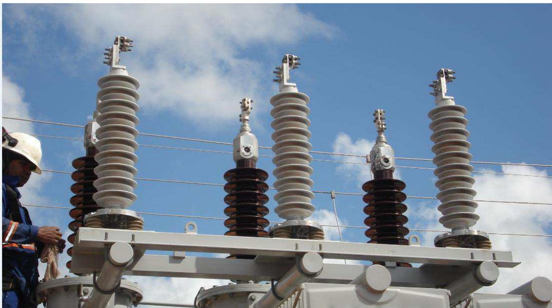
Figura 4.17 Instalação do para-raios do transformador principal.
