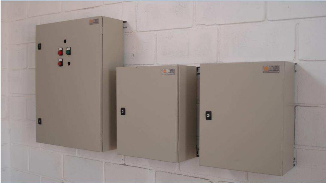
Figura 4.12 Instalação dos painéis de iluminação e tomadas.
