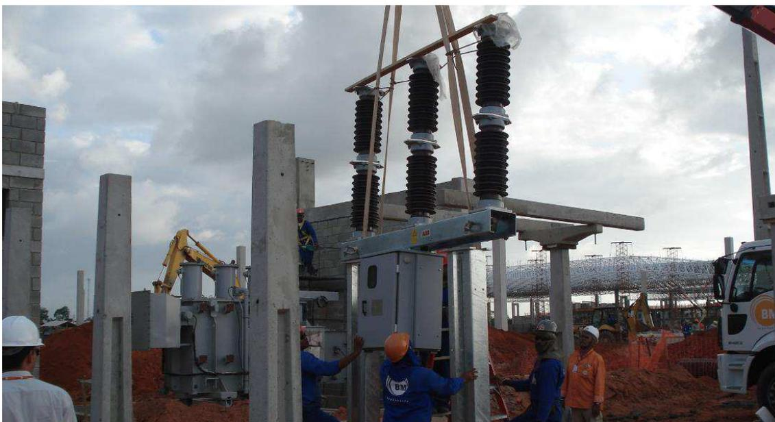
Figura 4.28 Instalação do disjuntor a SF<sub>6</sub>.
