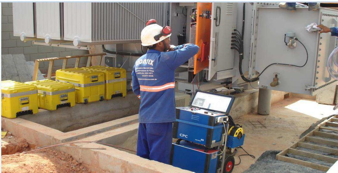
Figura 4.15 Comissionamento do transformador.
