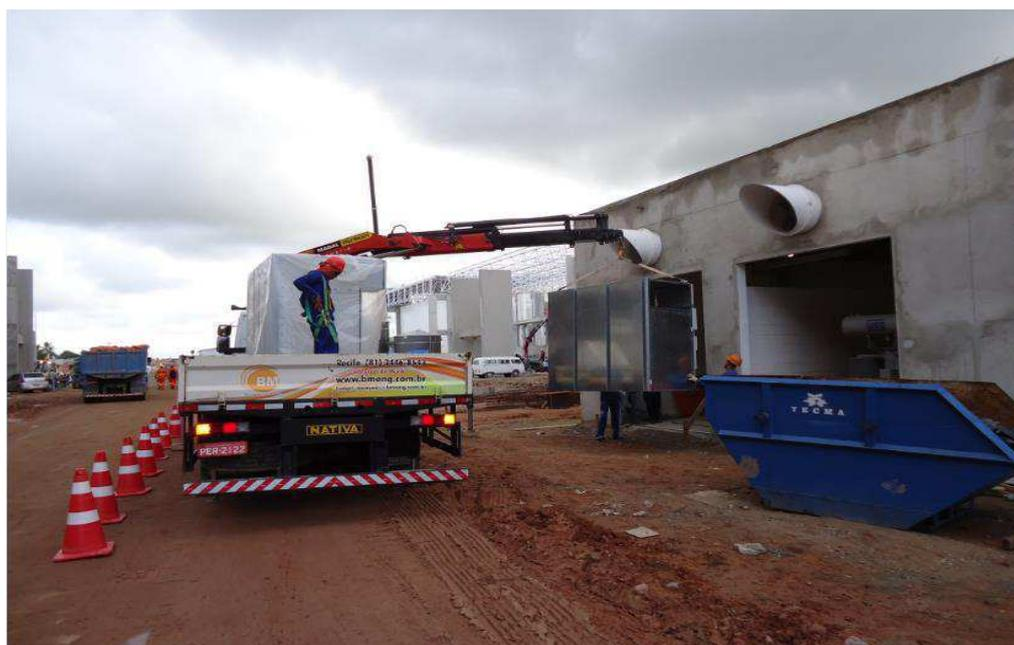
Figura 4.33 Instalação dos painéis na SE Utilidades.
