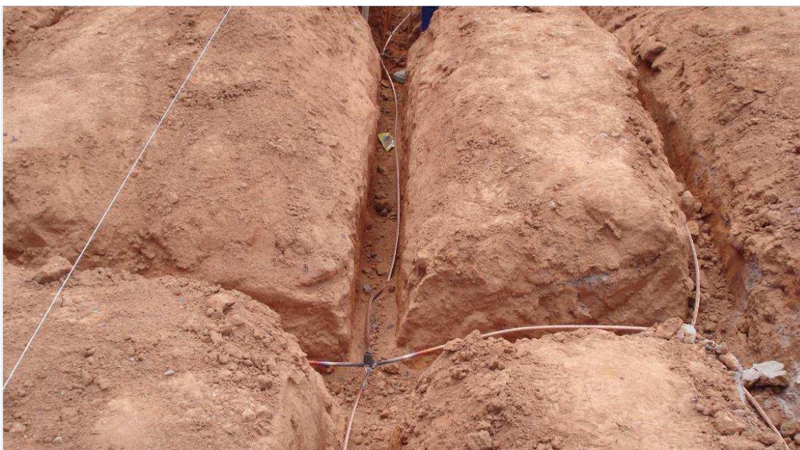
Figura 4.32 Malha de aterramento.
