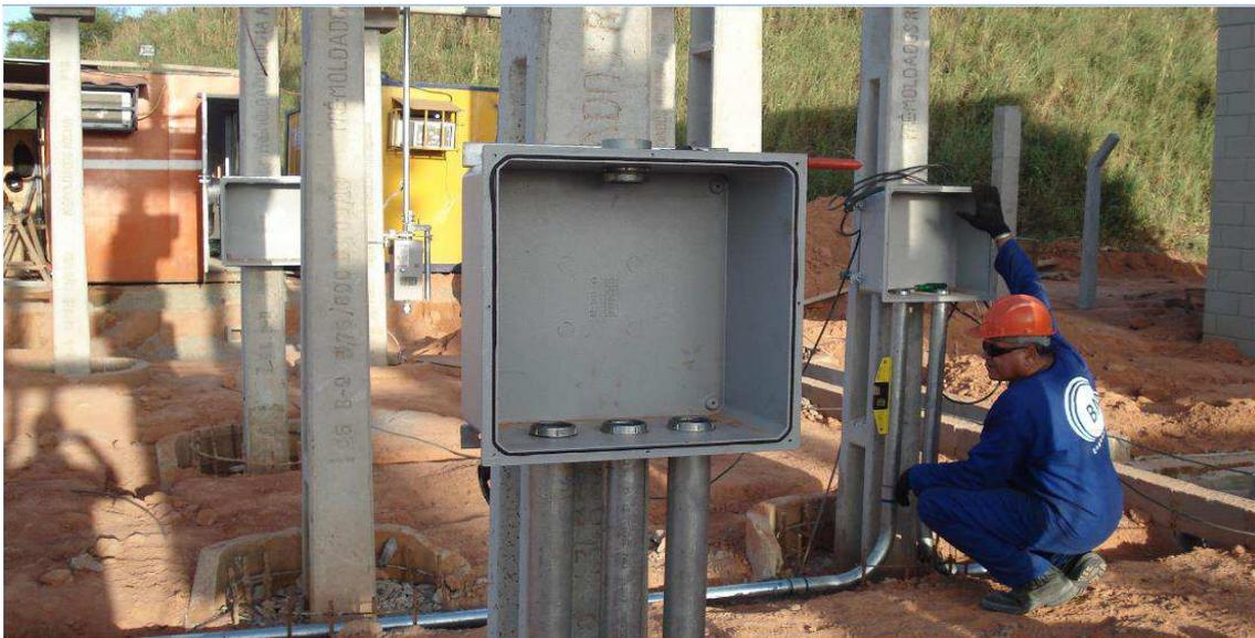
Figura 4.26 Instalação das caixas de passagem e eletrodutos dos TP e TC.
