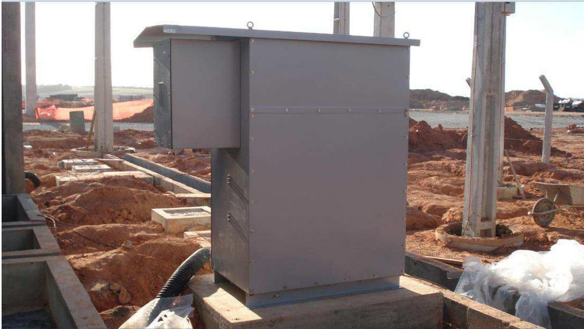
Figura 4.18 Resistor de aterramento.
