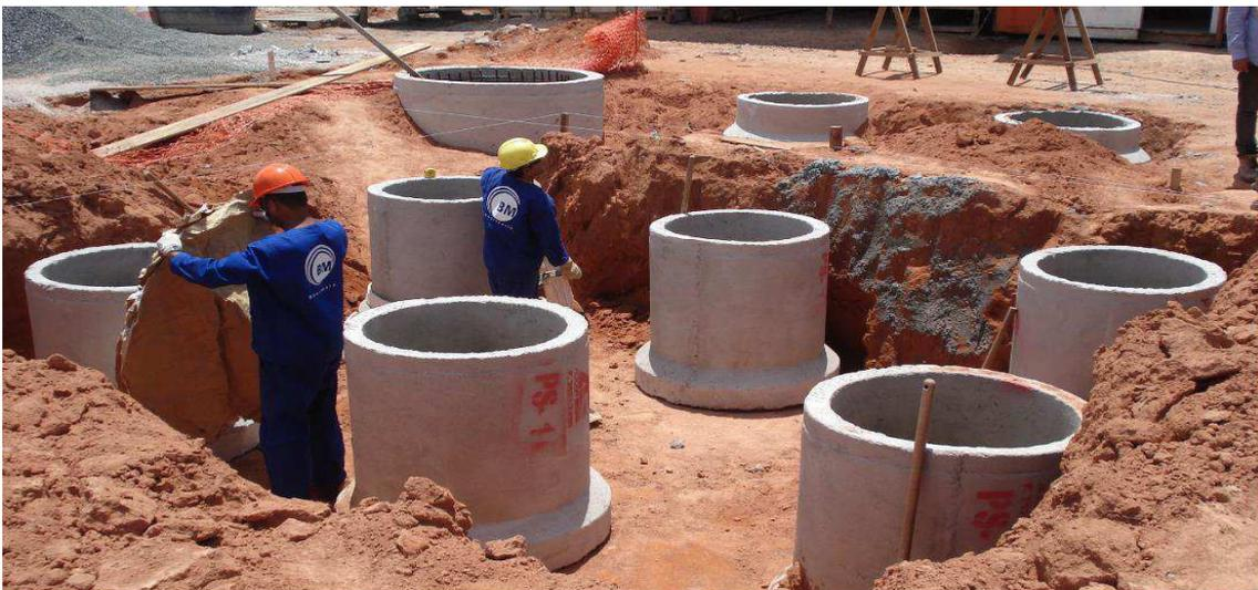
Figura 4.23 Anéis da base da chave seccionadora e demais equipamentos do pátio.
