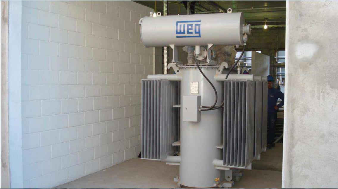
Figura 4.35 Transformador posicionado na SE Utilidades.
