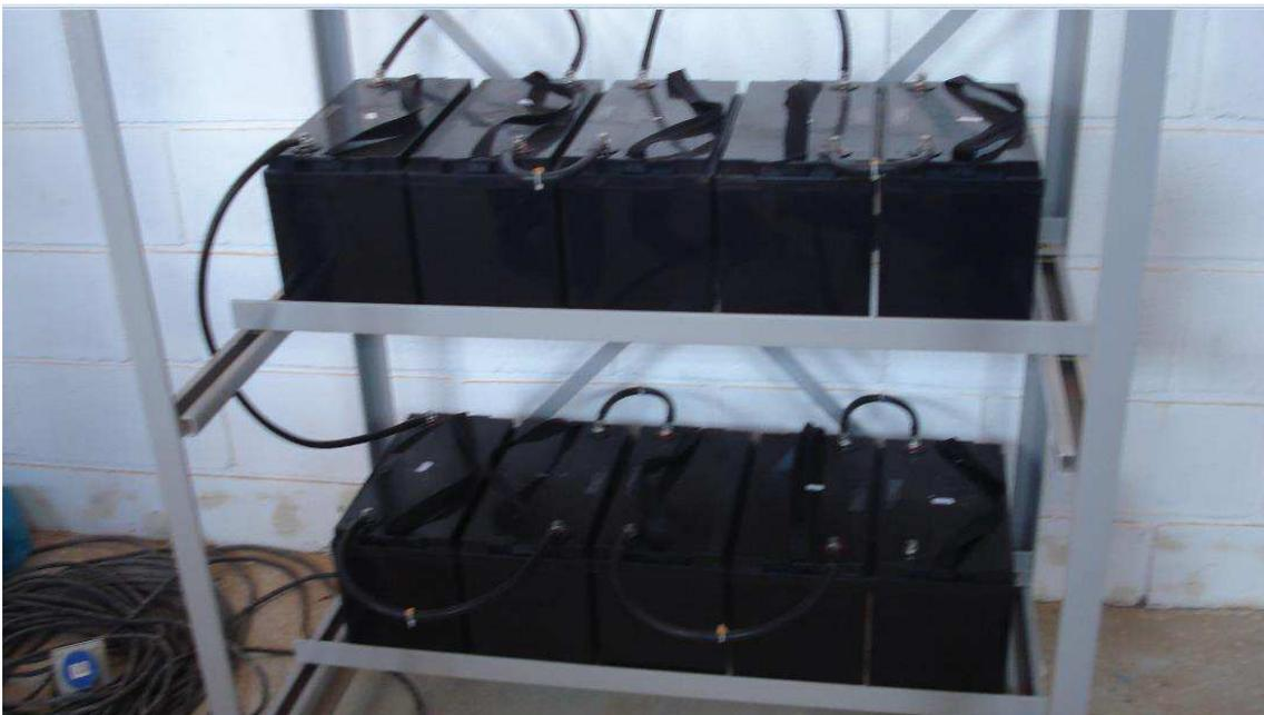
Figura 4.13 Banco de baterias para iluminação de emergência.
