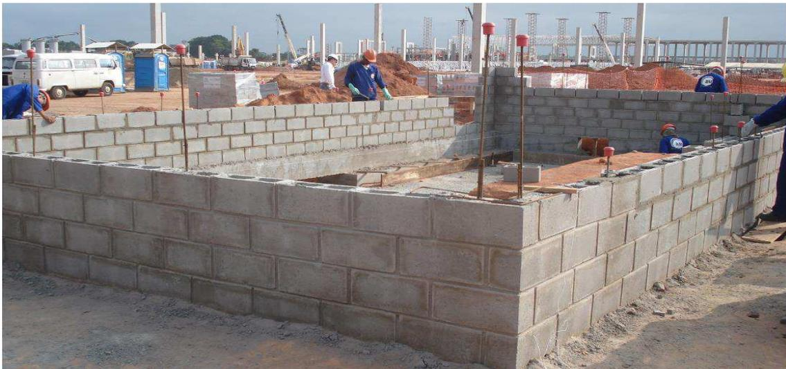
Figura 4.9 Alvenaria da casa de comando.
