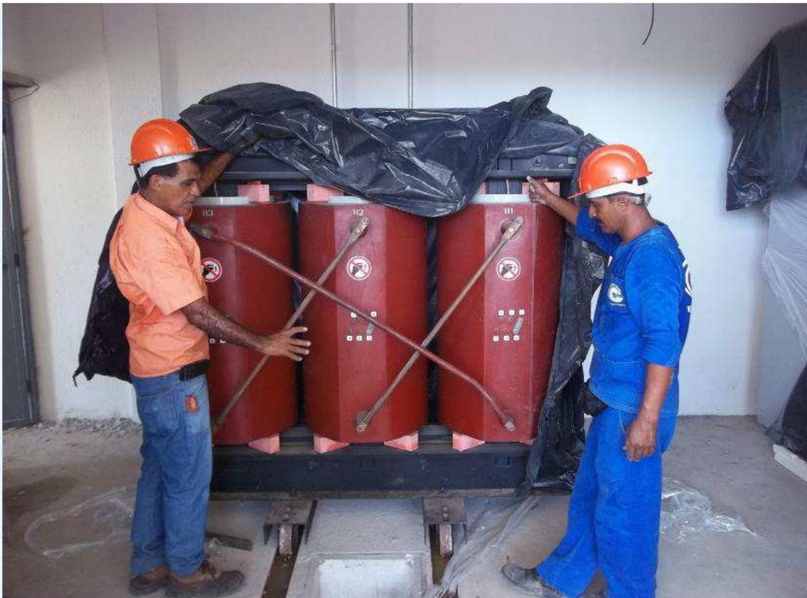
Figura 4.45 Instalação dos transformadores na respectiva base.
