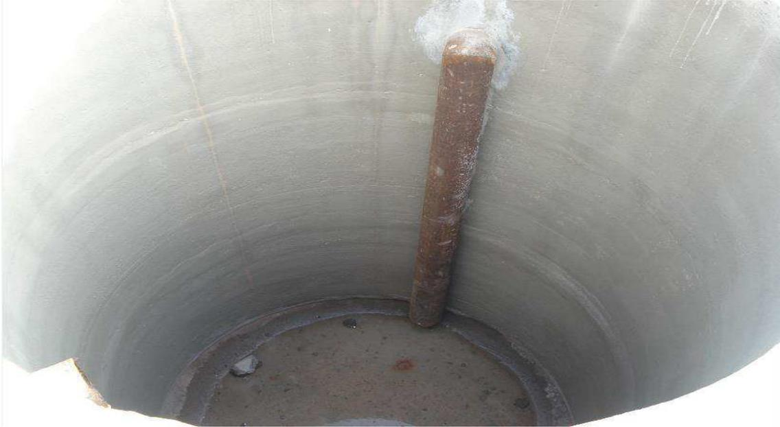
Figura 4.20 Caixa separadora de água e óleo.
