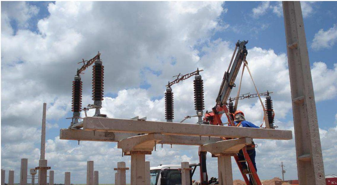
Figura 4.24 Montagem da chave seccionadora de abertura horizontal.
