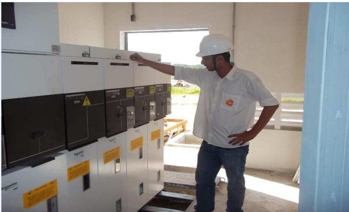
Figura 4.41 Acoplamento dos painéis de média tensão.
