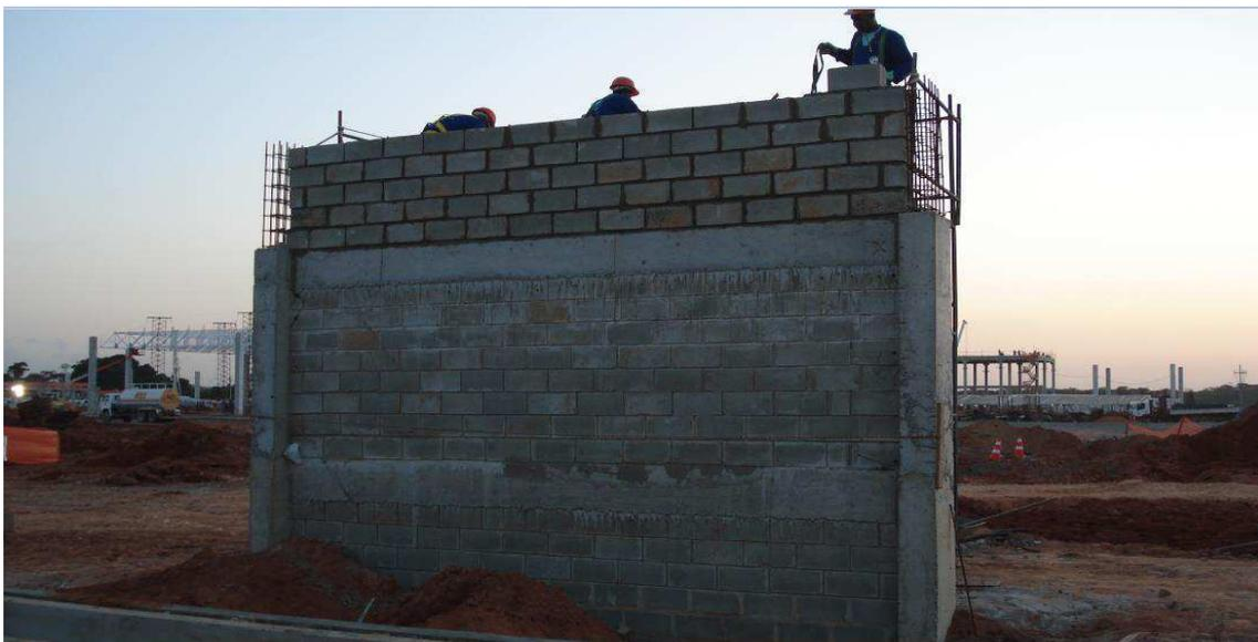
Figura 4.19 Etapa de alvenaria da parede corta-fogo.
