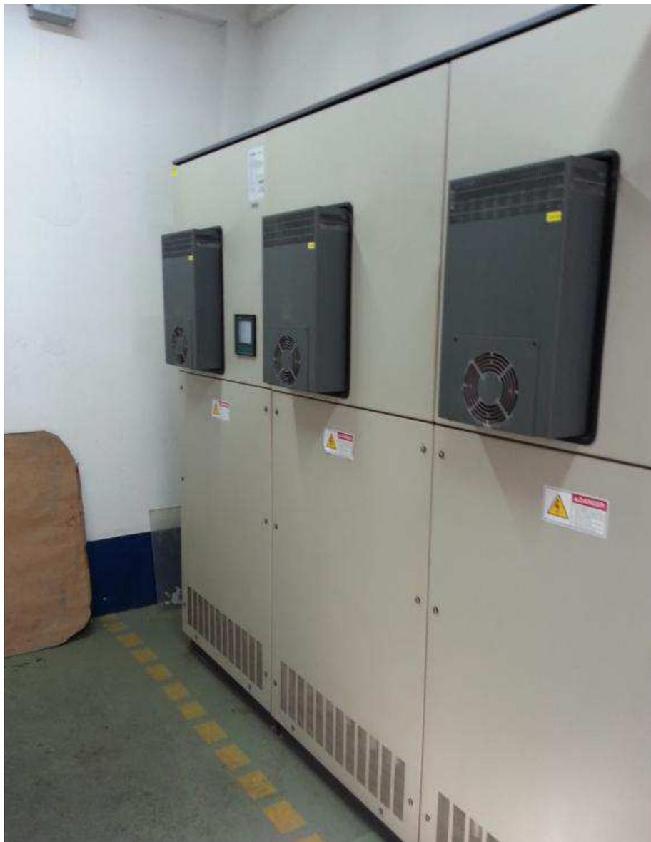
Figura 13 – Compensador de fator de potência 1440 kvar
