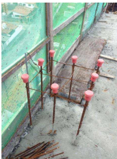
Figura 5 – Fotografia de um RE-BAR em pilar já concretado da obra.
