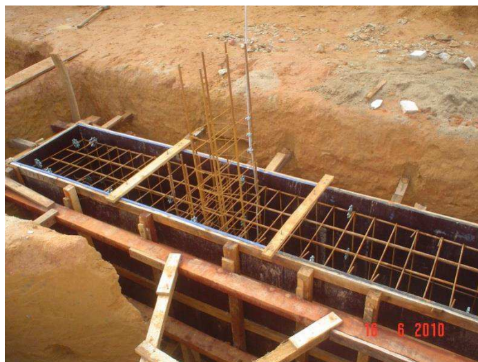
Figura 12 - Fotografia RE-BARS vertical partindo da fundação.
