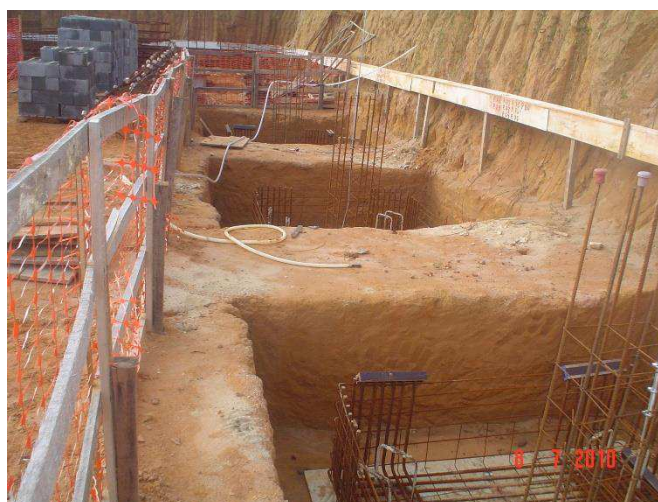
Figura 13 - Construção da fundação e alocação das RE-BARS.
