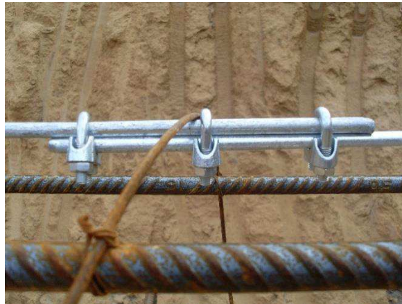
Figura 8- Conexão entre as RE-BARS feitas na obra.
