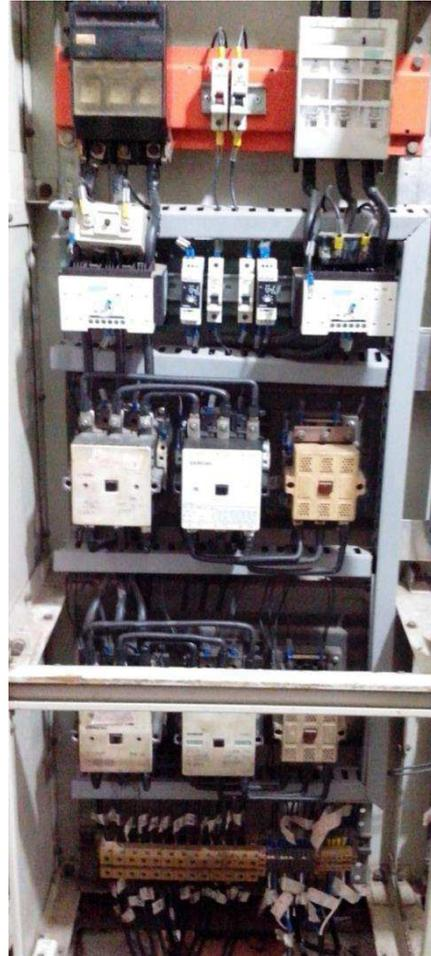
Figura 26 – As instalações renovadas do CCM .
