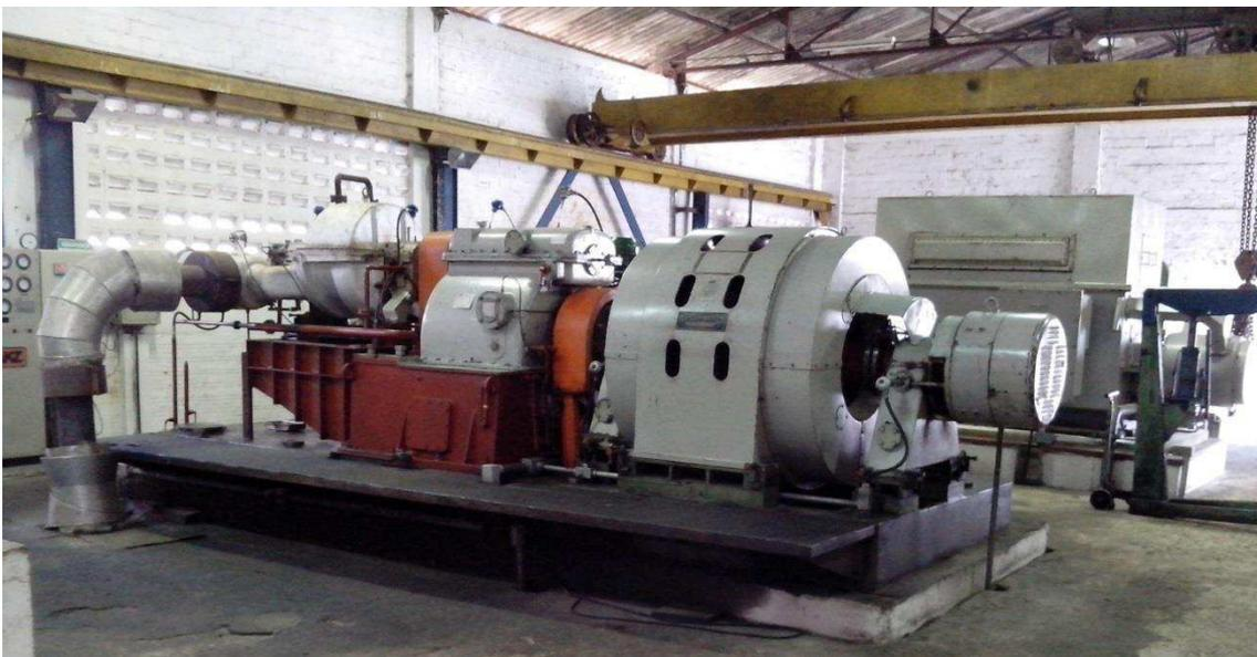
**Figura 6 – Casa de força: turbina, caixa de engrenagem e gerador síncrono trifásico de 1500kVA.**
