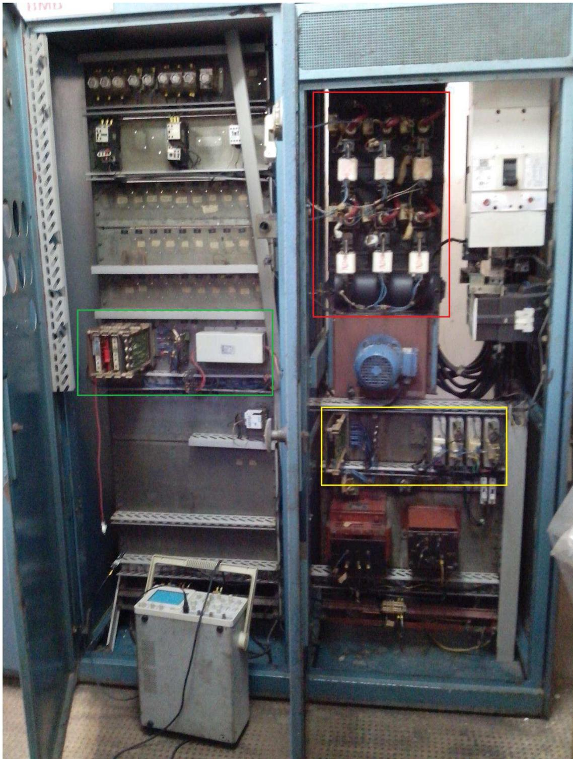
Figura 35 - Gabinete de controle do motor síncrono.
