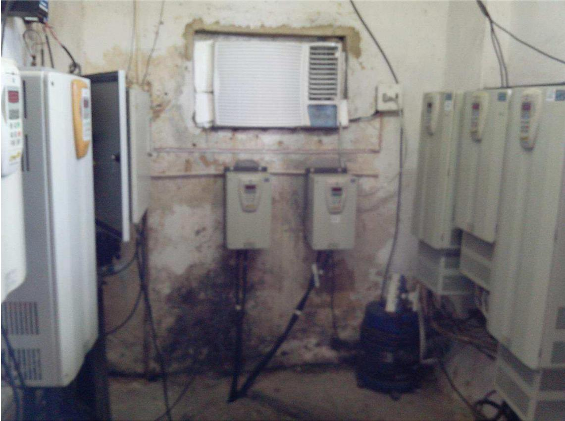
**Figura 22 - Abrigo climatizado dos inversores que controlam os equipamentos da moenda.**
