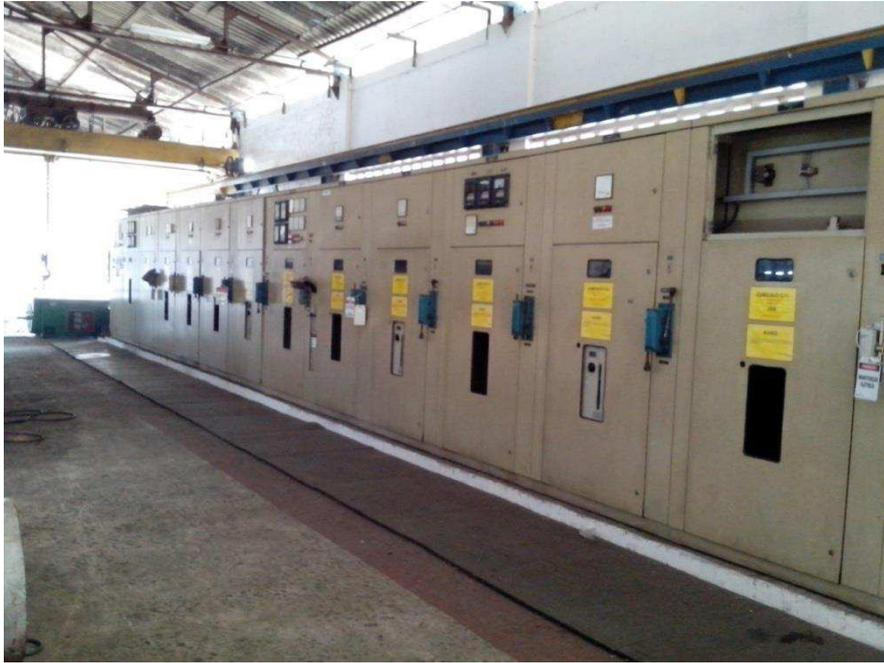
**Figura 5 – Casa de força: cubículos onde ficam instaladas as chaves de manobra e proteção.**
