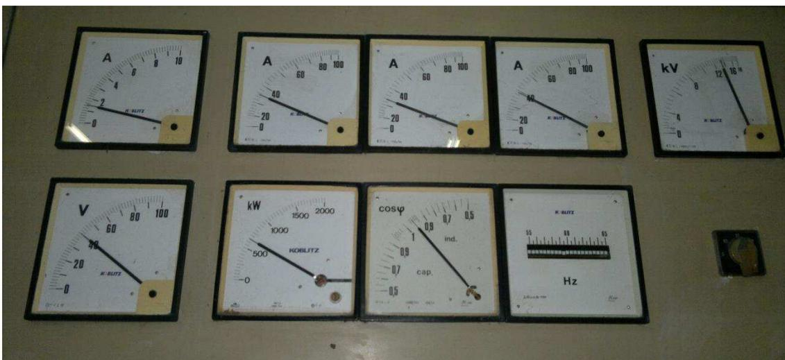
Figura 8 – Disposição dos instrumentos de medição na porta do cubículo.
