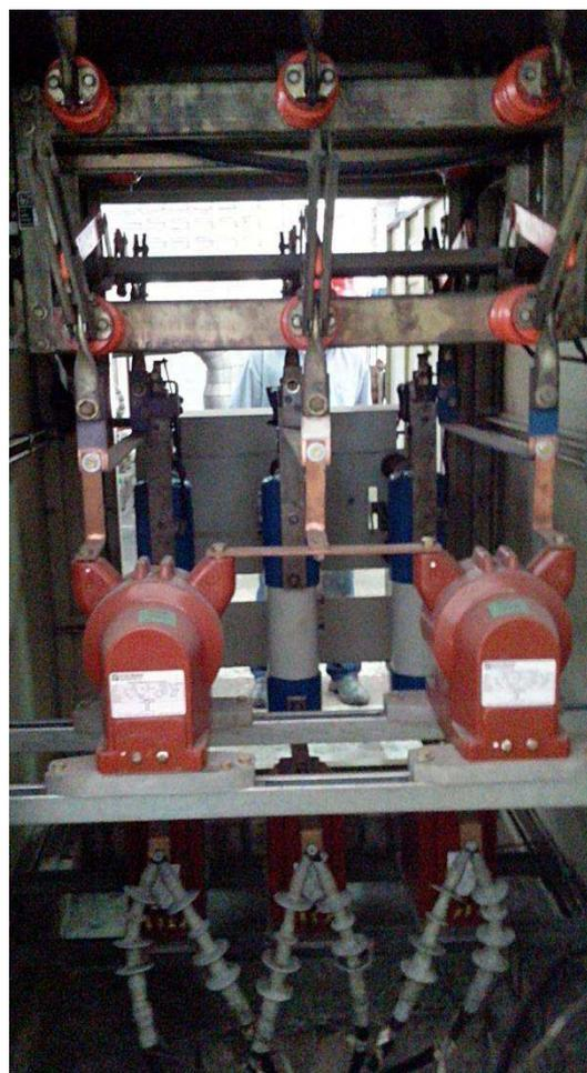
**Figura 12 - Novas instalações com dois TP's, três TC's e conjunto disjuntor ao fundo conectados ao barramento e cabos protegidos com mufas.**
