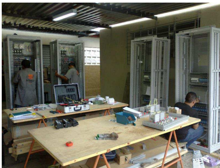
Figura 7 - Montagem dos chassis de proteção.
