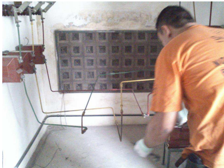
Figura 3. 3. – Técnico Preparando as conexões para fazer instalação do Disjuntor
