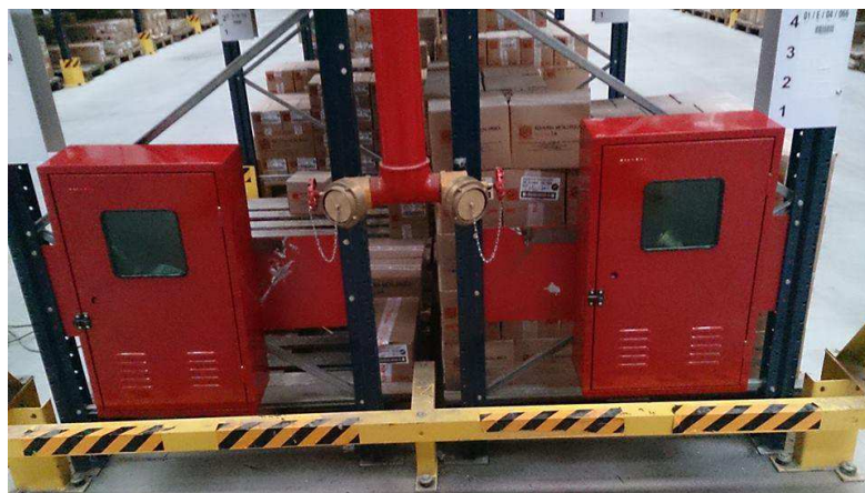
Figura 3. 12. – Abrigos instalados no CD de acordo com a norma
