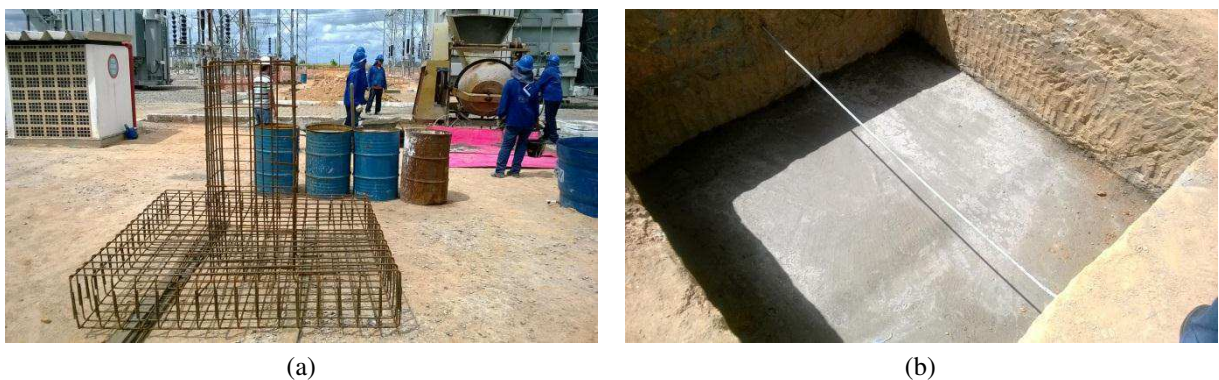
Figura 8. (a) Armação do DJ de 230 kV. (b) Escavação para base do DJ de 230 kV com concreto magro.
