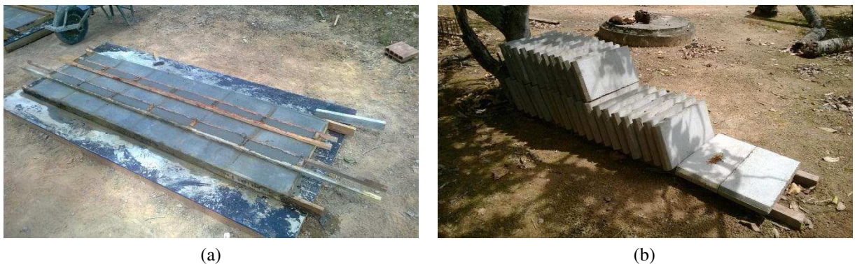
Figura 16. (a) Montagem de forma e concretagem das tampas para canaletas. (b) Tampas para canaletas concretadas.
