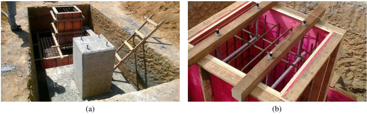
Figura 9. (a) Montagem de forma e base concretada do disjuntor de 138 kV. (b) Posição dos chumbadores do disjuntor de 138 kV.
