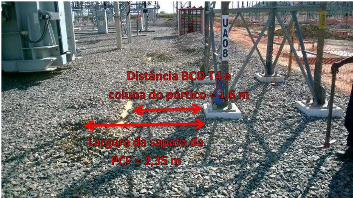
Figura 6. Interferência da BCO do transformador T4 para construção das sapatas da PCF.
