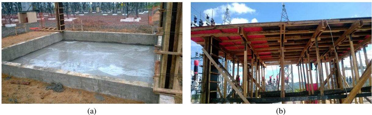
Figura 14. (a) Vigas do térreo concretadas. (b) Escoramento para cobertura.
