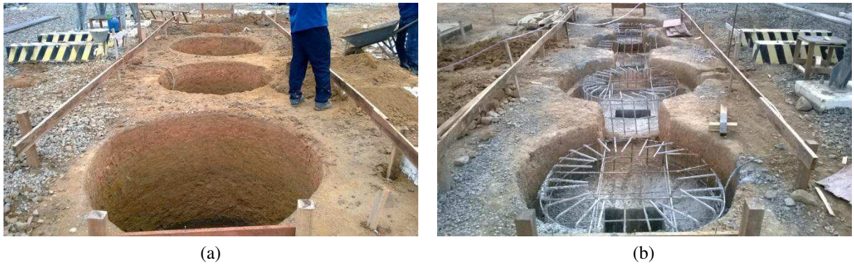
Figura 15. (a) Escavação da fundação da PCF. (b) Fundações concretadas.
