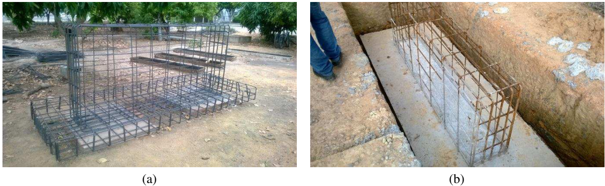
Figura 11. (a) Armagem da base da chave seccionadora de 230 kV. (b) Concretagem da base da chave seccionadora de 230 kV.
