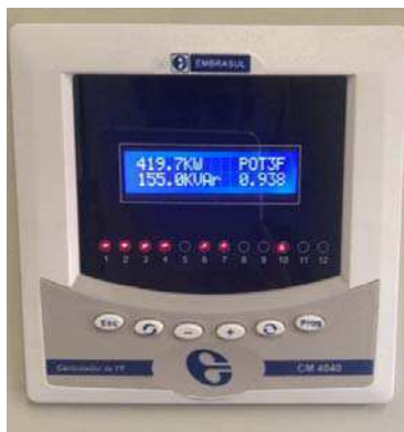
Figura 3.6 - Controlador de Fator de Potência CM4040 – EMBRASUL
