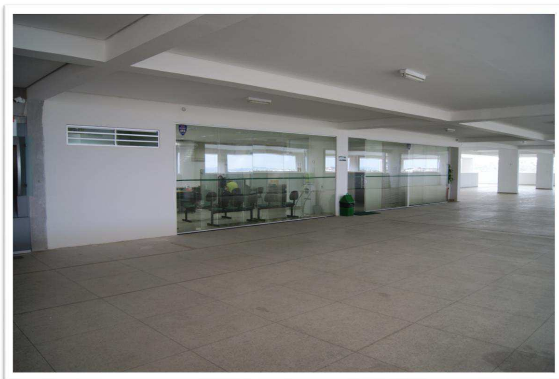
Figura 6 – Vista externa da obra concluída.
