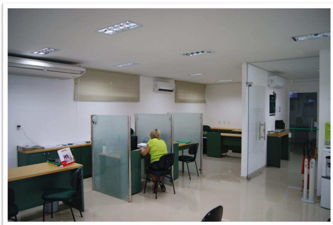
Figura 8 – vista interna da obra concluída.
