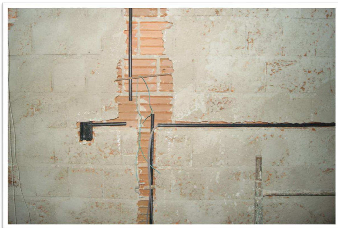
Figura 4 – Passagem de eletrodutos.
