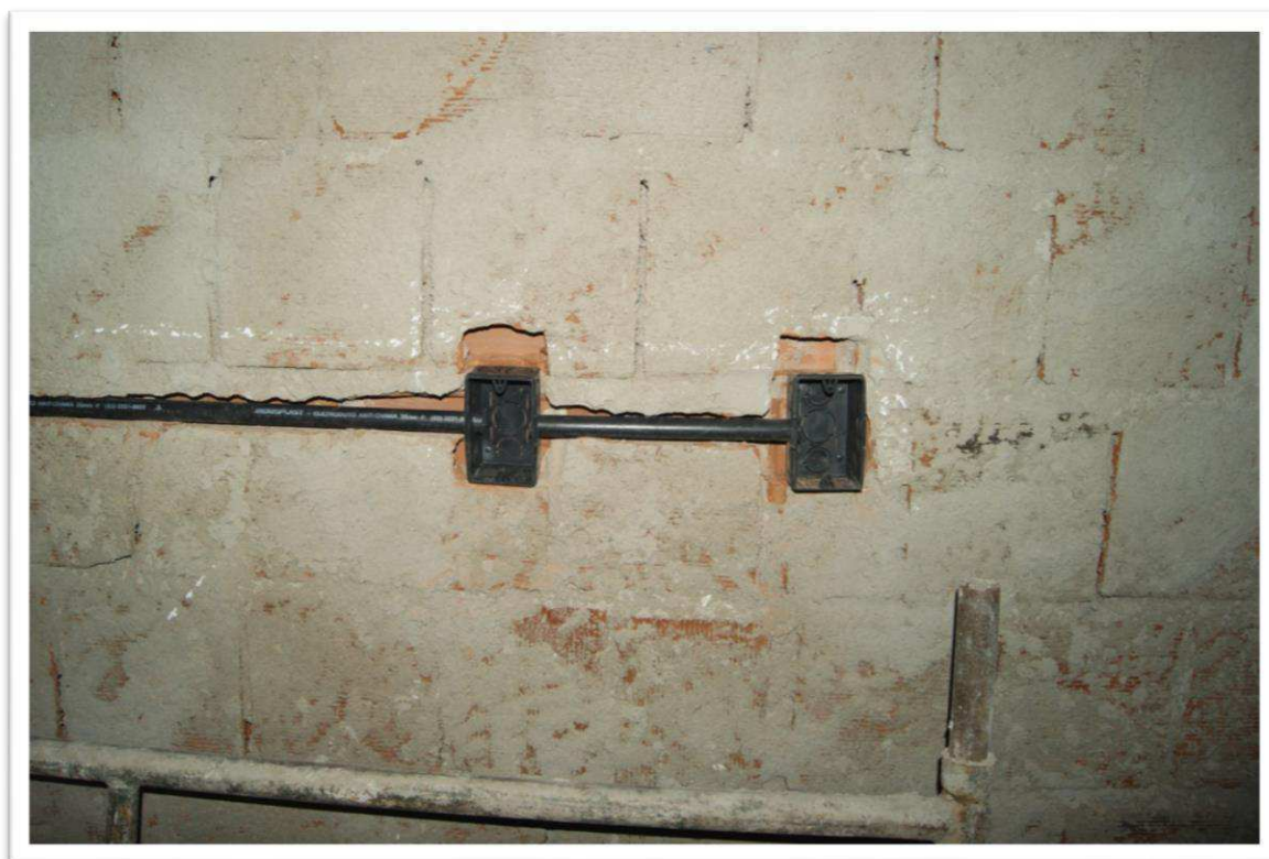
Figura 5 – Instalação de tomadas.
