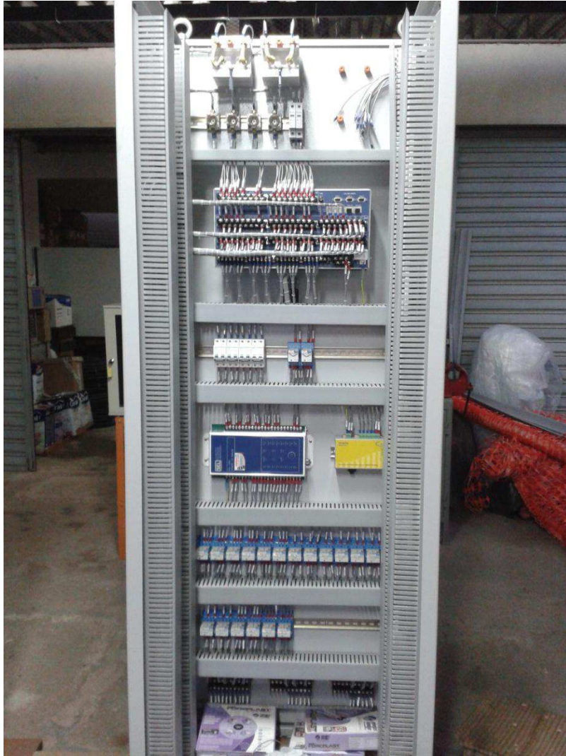
Figura 5. Parte traseira de um painel de proteção.
