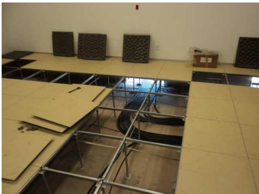
Figura 7 - Cabos sendo direcionado para o seu painel de origem/destino no interior da cabana de relés.
