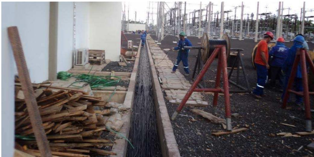
Figura 6 - Preparação das bobinas de cabos do SDMPCCS para serem colocadas nos cavaletes.
