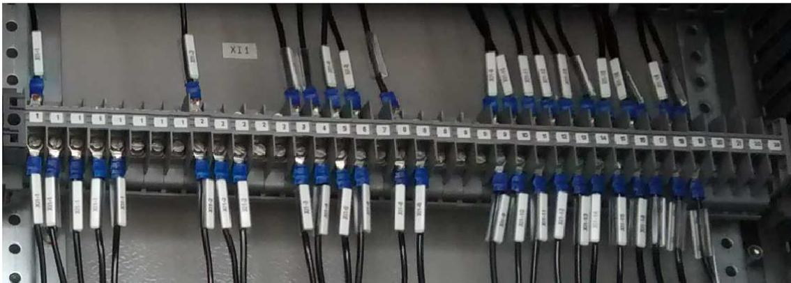
Figura 16 - Detalhes das anilhas colocadas nas veias dos cabos.
