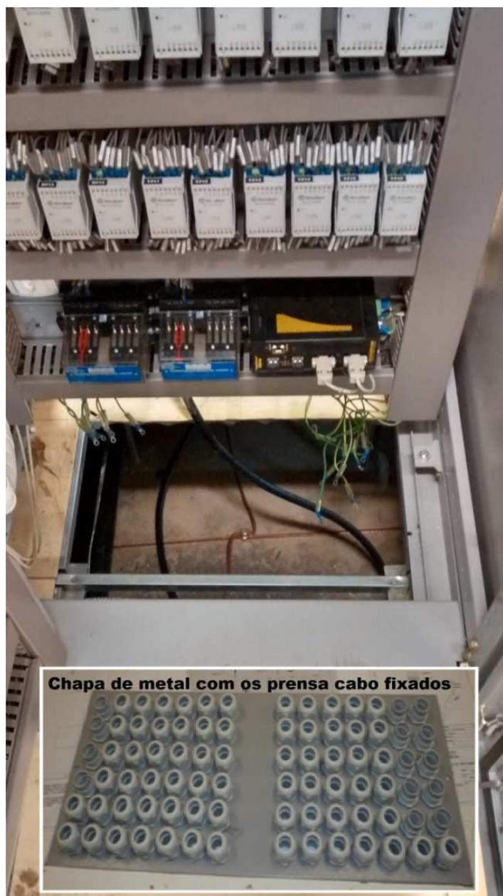
Figura 8 - Local de fixação da chapa de metal no piso do painel.
