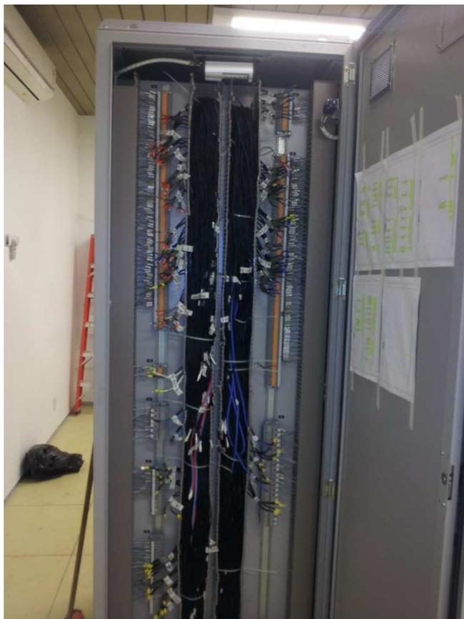
Figura 15 - Vista da parte traseira do painel com todas as veias distribuídas de acordo com os diagramas de interligação que estão fixados na parte interna da porta.
