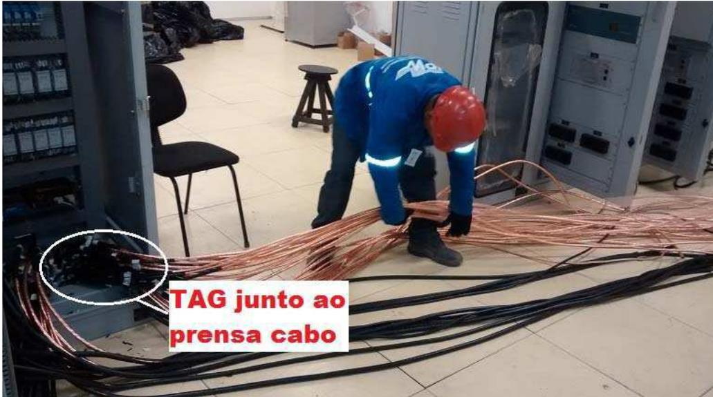
Figura 9 - Detalhe da recolocação da TAG que estava na ponta do cabo para perto do prensa cabo para agilizar a realização do Passo 2.
