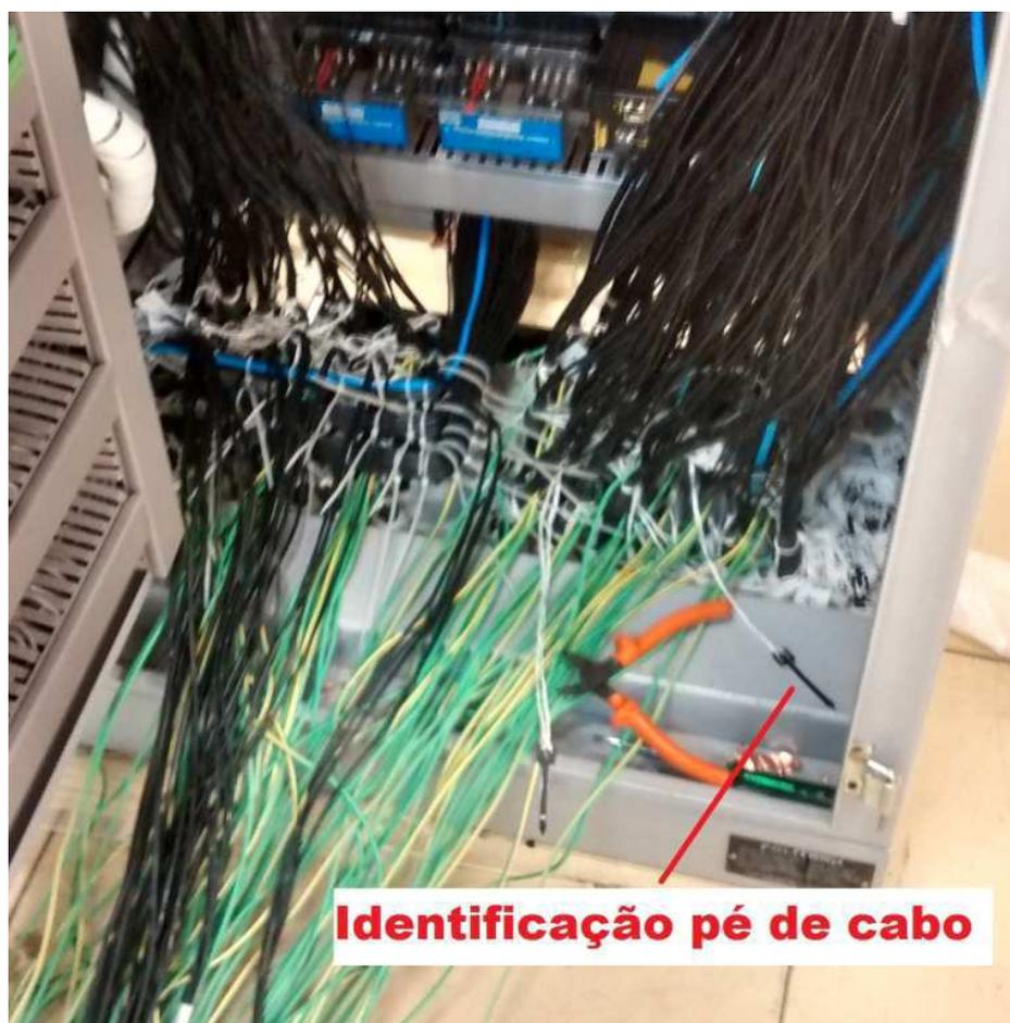
Figura 12 - Início da laboração do chicote; os cabos estão sendo separados e presos de modo a formar um caminho, resistente e rígido, em direção a parte traseira do painel e em detalhe a identificação pé de cabo.
