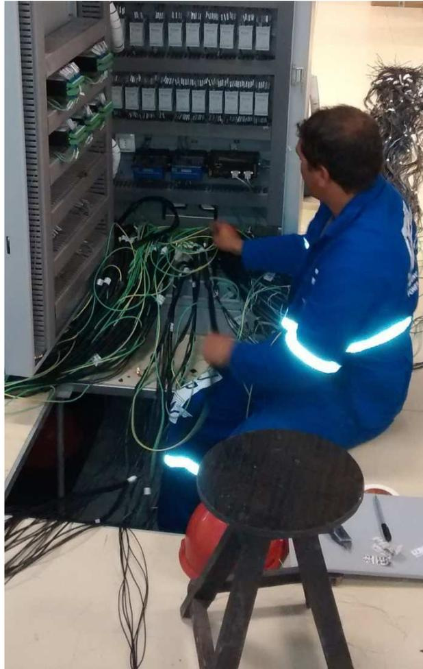
Figura 10 - Funcionário realizando a solda do "rabicho de terra" e a "ponta de lápis".
