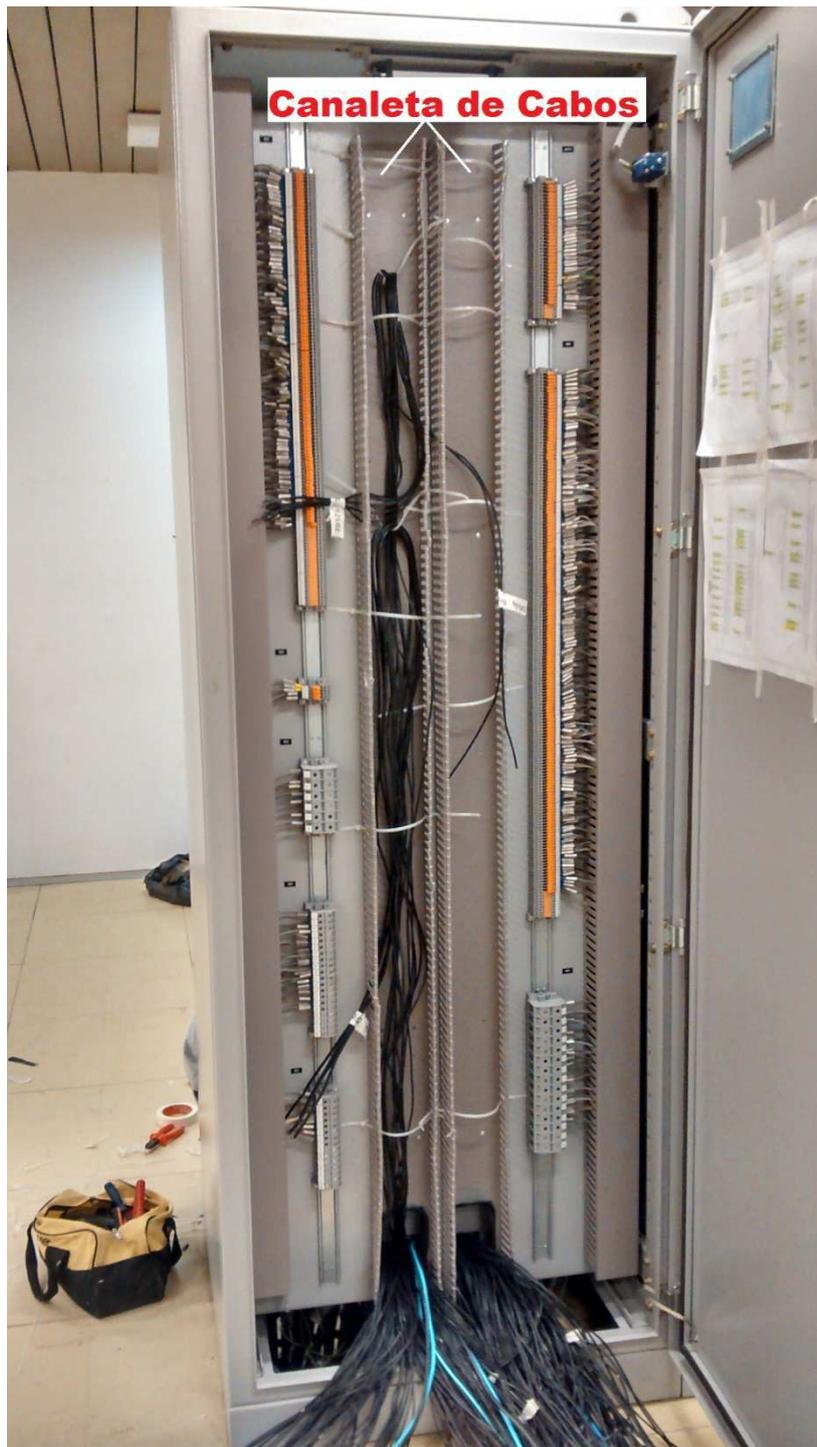
Figura 14 - Início da distribuição das veias para os bornes e régua. Os cabos são distribuídos de modo a ter uma sobra para uma eventual mudança de local do borne ou régua.
