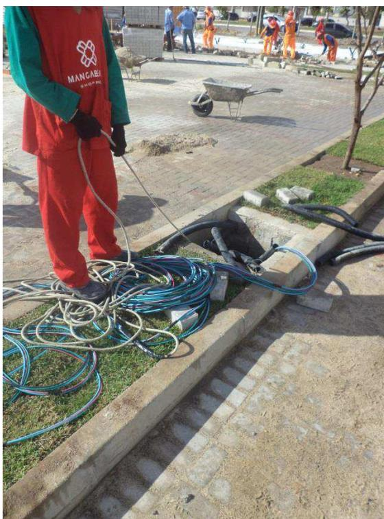
FIGURA 7 - CABEAMENTO DOS POSTES
