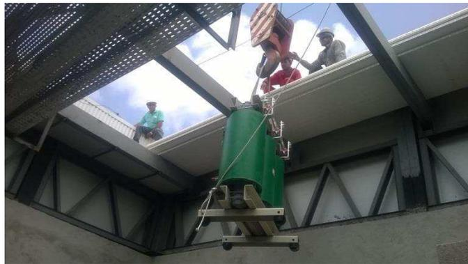
FIGURA 13 - GUINCHO LEVANDO TRANSFORMADOR PARA SUBESTAÇÃO
