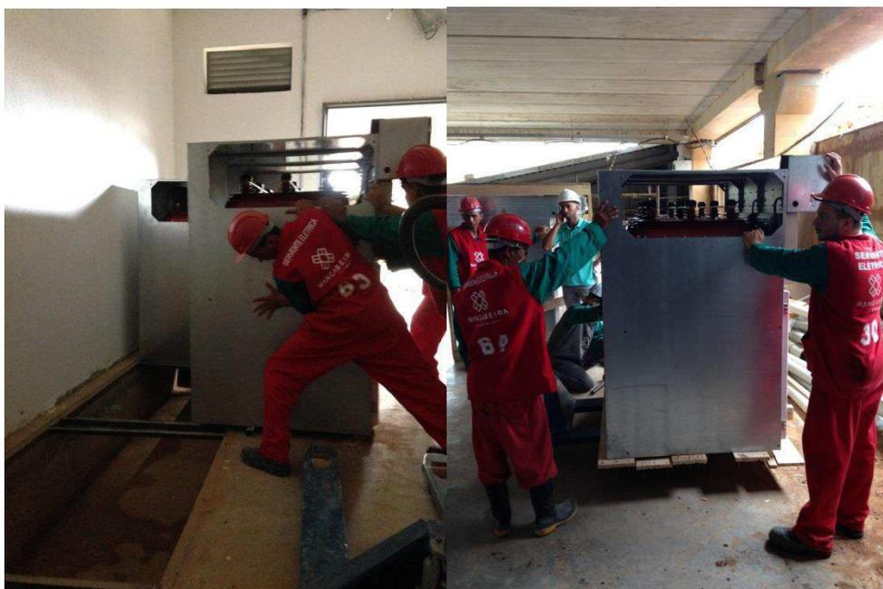
FIGURA 12 - ALOCAÇÃO DOS EQUIPAMENTOS DA SUBESTAÇÃO
