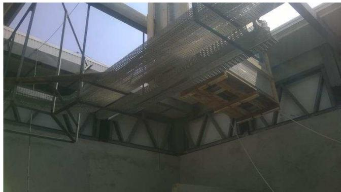
FIGURA 14 - GUINCHO LEVANDO QUADRO DE MEDIÇÃO PARA SUBESTAÇÃO
