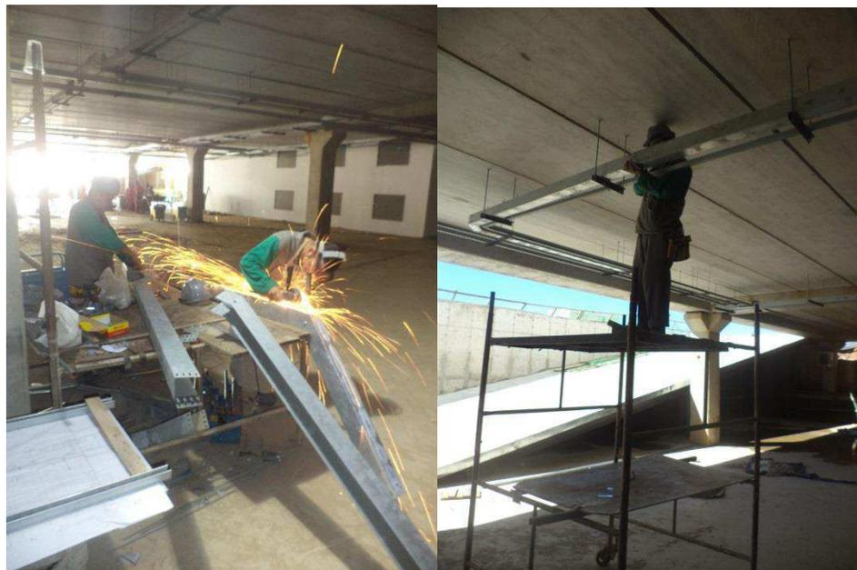
FIGURA 18 - (A) MONTAGEM DE ELETROCALHA; (B) INSTALAÇÃO DE ELETROCALHA
