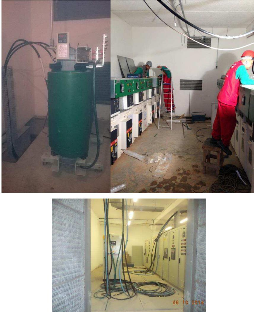
FIGURA 16 - (A) TRANSFORMADOR LIGADO; (B) ELETRICISTAS LIGANDO PAINÉIS DE DISJUNÇÃO; (C) CABOS PRONTOS PARA SEREM FECHADOS NOS EQUIPAMENTOS
