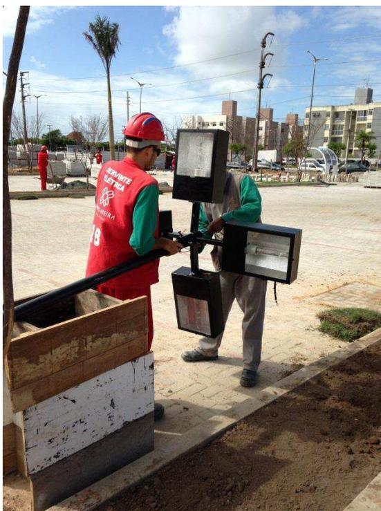
FIGURA 8 - LEVANTAMENTO DOS POSTES
