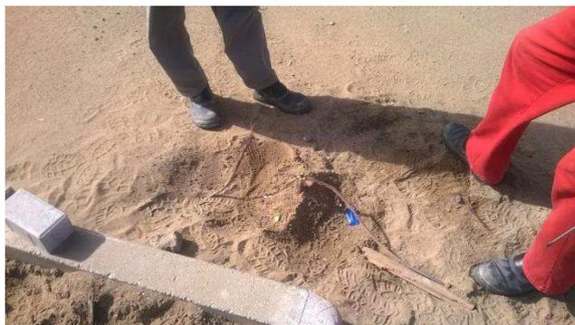
FIGURA 11 - MALHA DE ATERRAMENTO ROMPIDA PELA CIVIL
