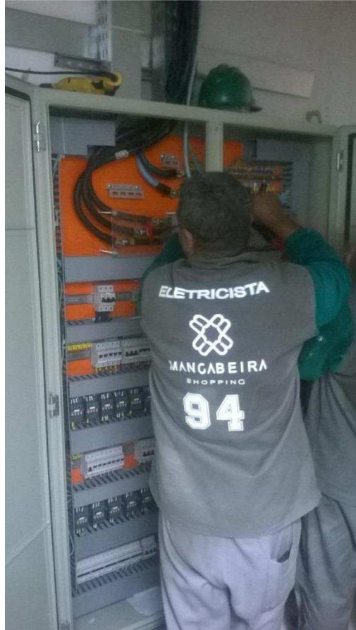
FIGURA 22 - FECHAMENTO NO QUADRO DOS CIRCUITOS DE IUMINAÇÃO, TOMADA E SOM
