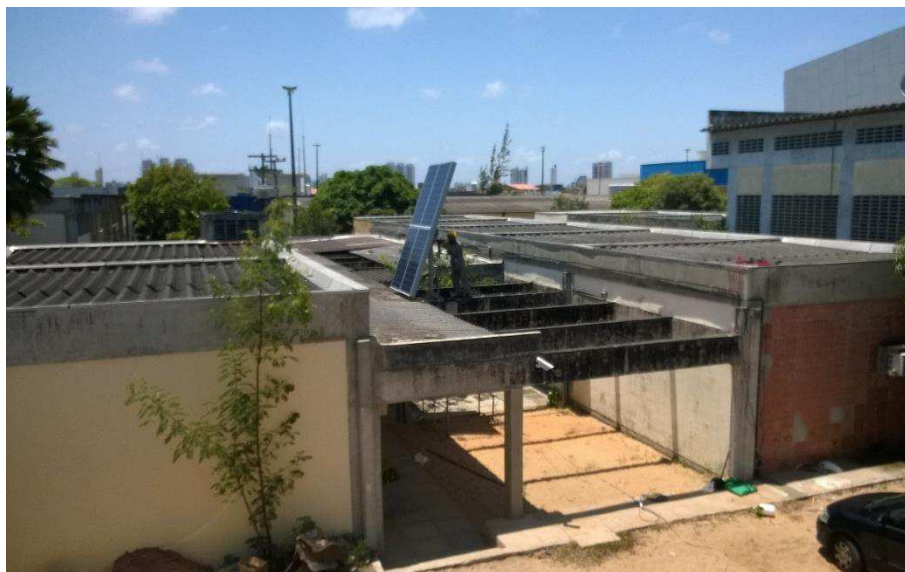
Figura 5.12 – Fotografia do processo de conexões elétricas dos painéis fotovoltaicos da planta rastreadora no LEPER/UFRN.
