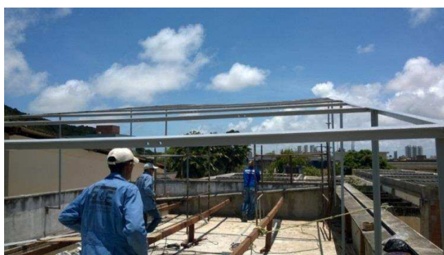
Figura 5.4 – Fotografia da instalação das estruturas metálicas do suporte dos arranjos de painéis fotovoltaicos das plantas fixas no LEPER/UFRN.
