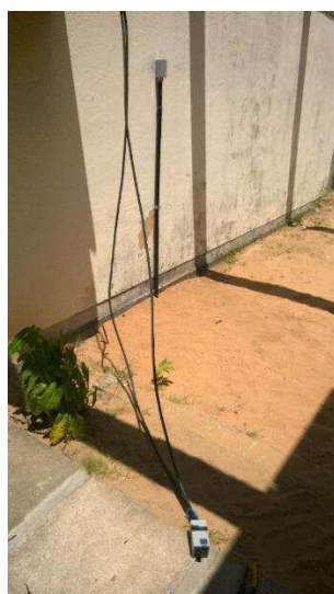
Figura 5.15 – Fotografia instalação da chave de testes do funcionamento do motor da planta rastreadora.
