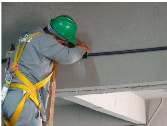
Figura 5.21 – Fotografia do processo de fixação de condutores de PVC no Estádio Ernani Sátiro em Campina Grande - PB.
