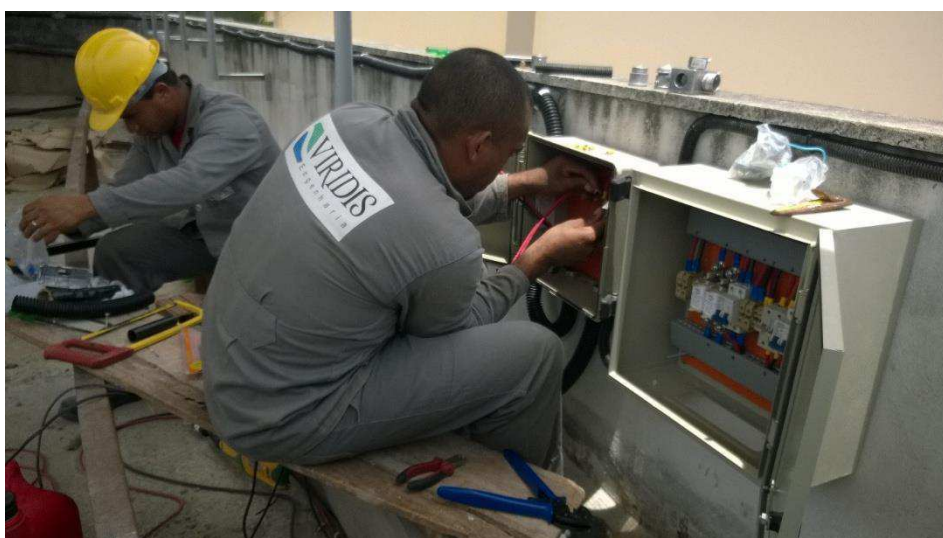
Figura 5.9 – Fotografia do processo de conexão dos arranjos de painéis fotovoltaicos das plantas fixas aos quadros elétricos no LEPER/UFRN.
