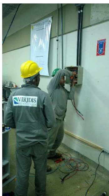
Figura 5.13 – Fotografia da instalação do quadro geral das plantas fixas e rastreador no LEPER/UFRN.
