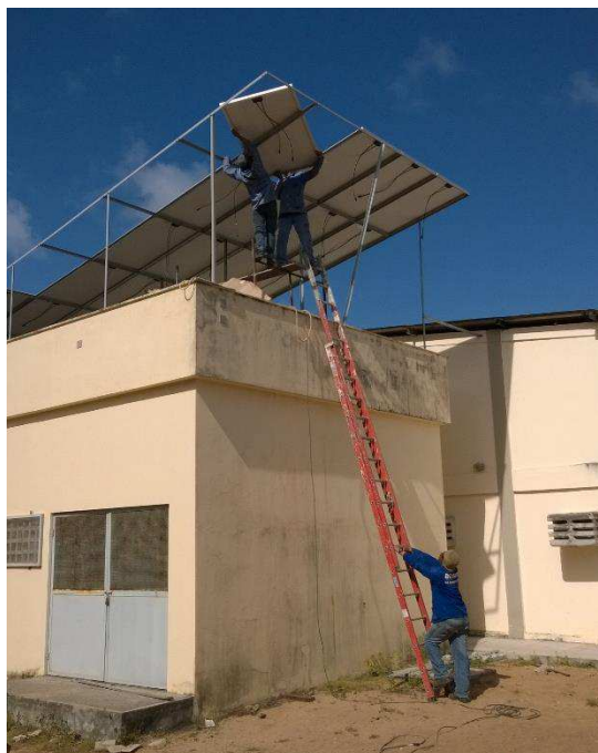
Figura 5.6 – Fotografia da fixação dos arranjos de painéis fotovoltaicos das plantas fixas no suporte metálico no LEPER/UFRN.
