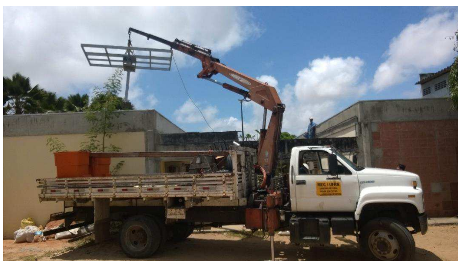
Figura 5.11 – Fotografia do içamento da estrutura metálica de suporte do arranjo de painéis fotovoltaicos da planta rastreadora no LEPER/UFRN.
