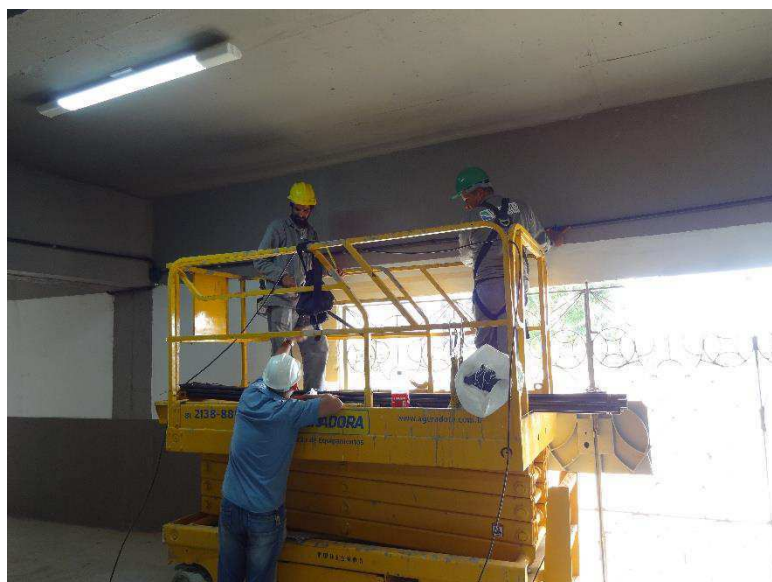
Figura 5.20 – Fotografia do processo de fixação de eletrodutos rígidos de PVC e luminárias, utilizando plataforma elevatória do tipo tesoura, no Estádio Ernani Sátiro em Campina Grande - PB.
