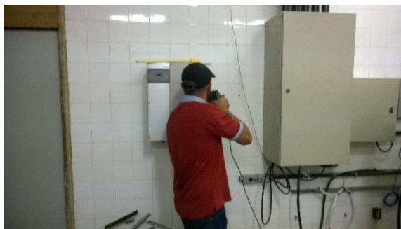
Figura 5.17 – Fotografia do processo de fixação do inversor instalado no Laboratório de Sistemas Fotovoltaicos da UFCG.
