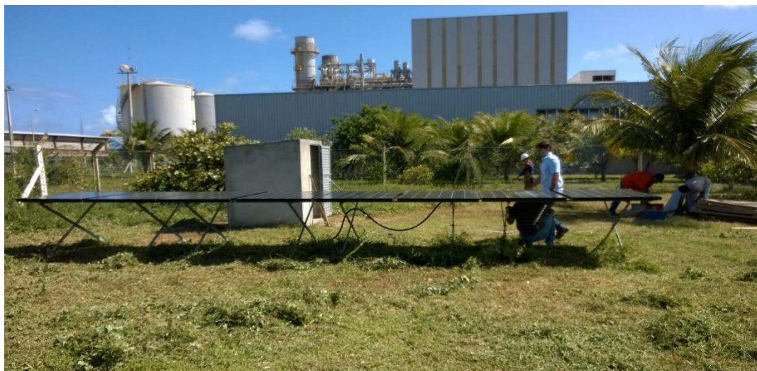
Figura 5.2 – Fotografia da fixação nos suportes e conexões elétricas do arranjo de painéis instalados.
