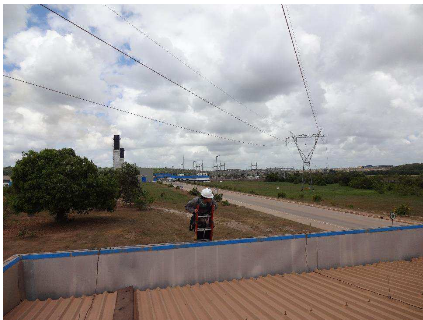
Figura 5.24 – Fotografia do processo de inspeção visual do SPDA da parte superior da guarita da EPASA em João Pessoa - PB.
