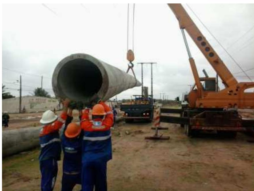
Figura 4.22 – Auxílio do guindaste no transporte e implantação dos postes.
