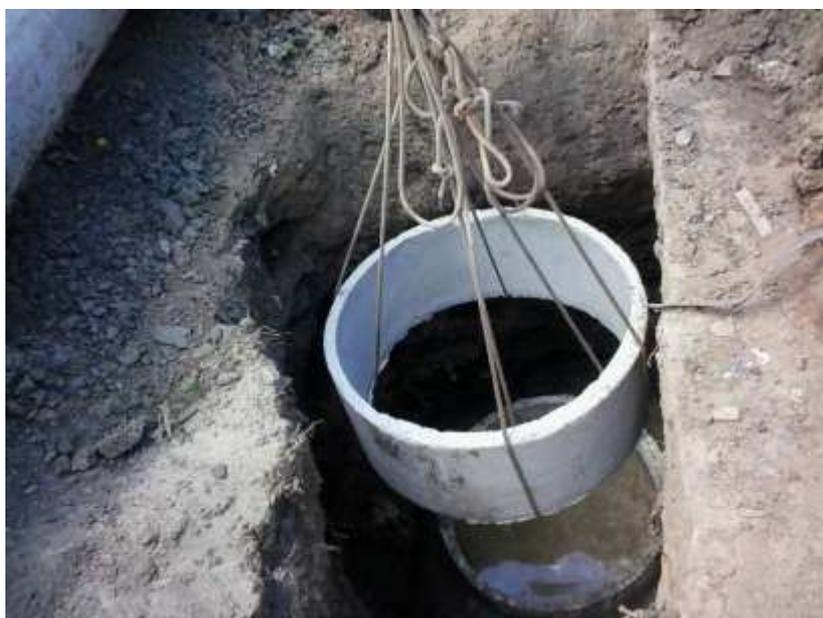
Figura 4.24 –Tubulões sendo implantados em uma fundação.
