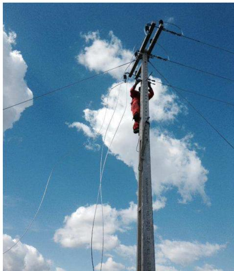
Figura 11: Colaborador passando condutores.
