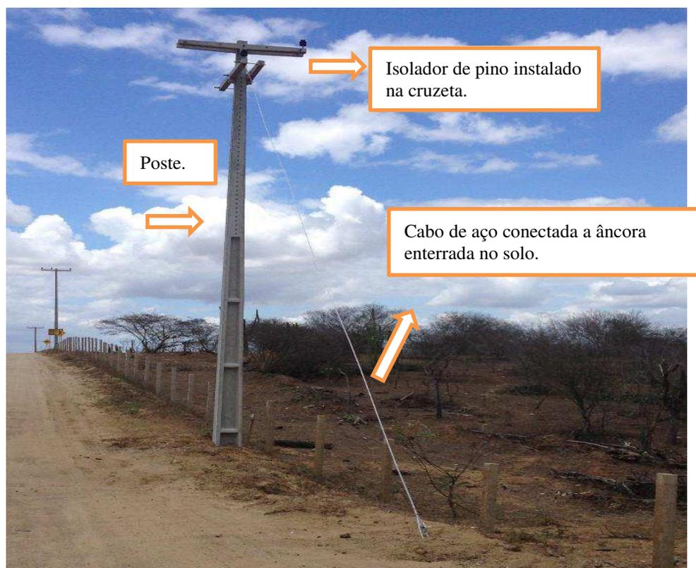
Figura 9: Poste com cruzetas e conectada com cabo de aço à âncora enterrada no solo.
