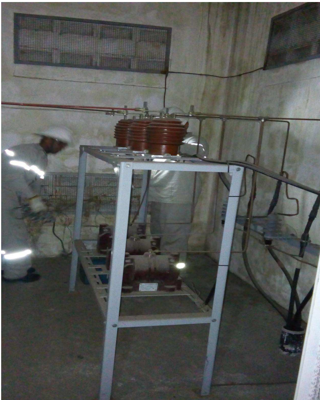
Figura 14- Cubículo de medição.
