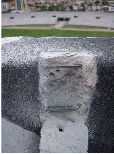
Figura 37 - Fotografia de um ponto de medição da resistência de aterramento.
