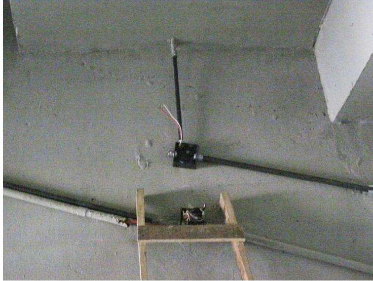
Figura 25 – Fotografia da substituição da instalação antiga pela nova.
