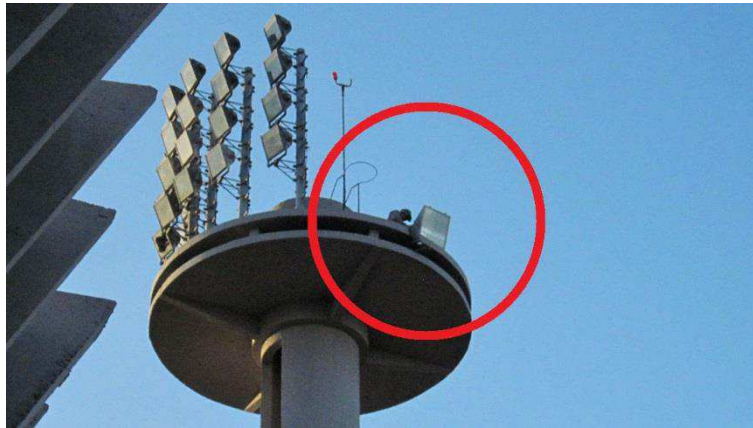
Figura 19 – Fotografia de um eletricista da Viridis Engenharia fixando um refletor de 2000 W em uma das torres de iluminação.
