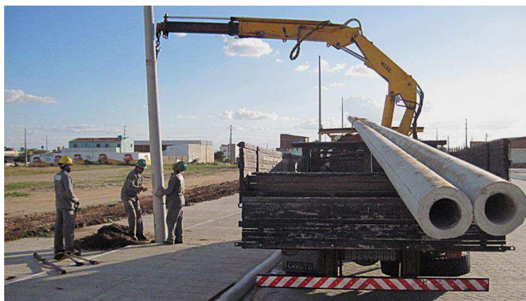
Figura 12 – Fotografia do postejamento realizado pela equipe da Viridis com auxílio de um muque de força.
