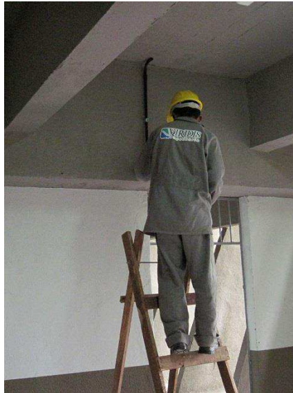
Figura 24 – Fotografia da equipe da Viridis Engenharia realizando a fixação de eletrodutos.
