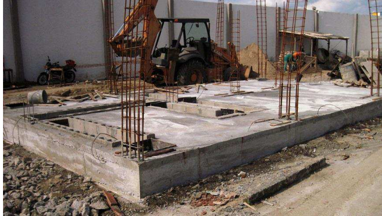
Figura 44 – Fotografia da construção da subestação.
