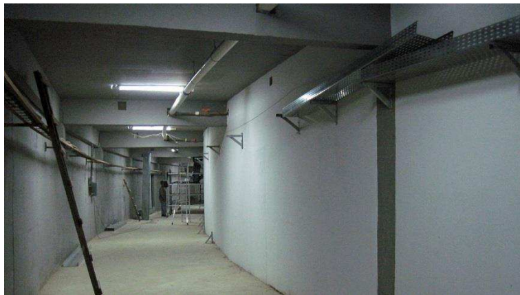
Figura 26 – Fotografia da instalação das eletrocalhas no túnel.
