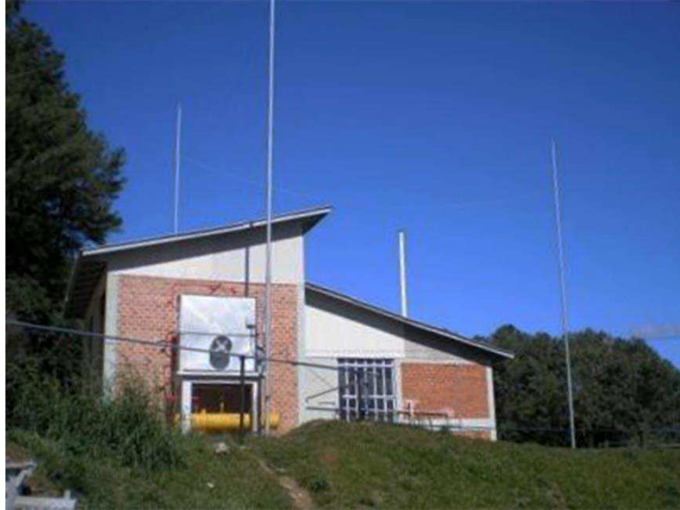
Figura 6 – Fotografia de SPDA tipo eletrogeométrico Fonte: BOETEC INSTALAÇÕES, 2014.
