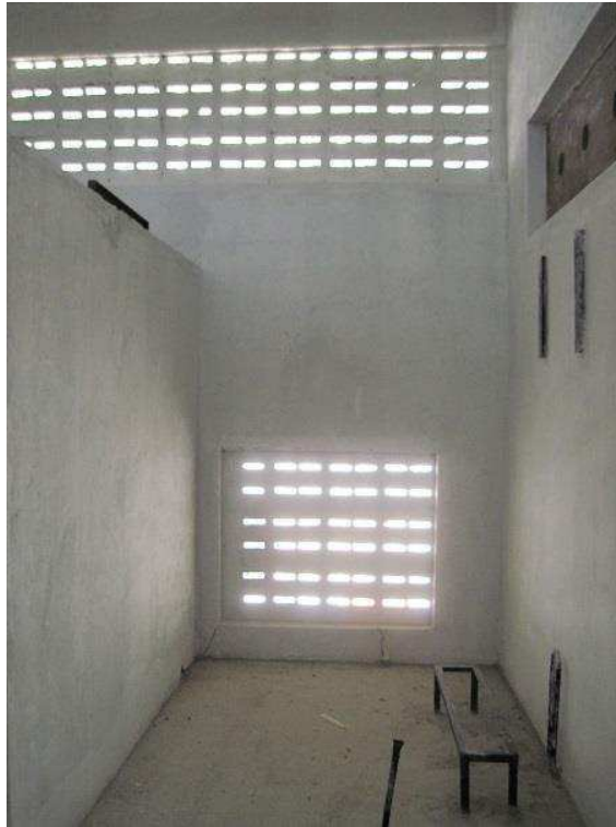
Figura 45 – Fotografia do interior da subestação, na qual podem ser vistos alguns suportes já fixados.
