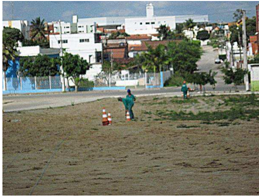
(a) Equipe sinalizando a passagem com cones.
