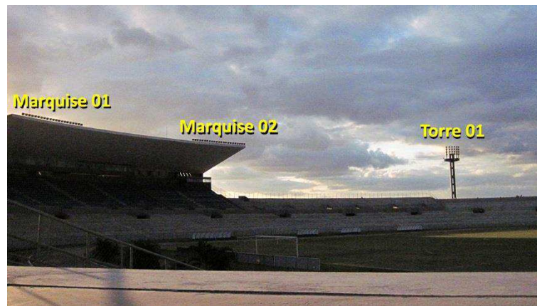
Figura 31 – Fotografia do Estádio O Amigão, na qual podem ser vistas a torre de iluminação 1 e os conjuntos de refletores no topo da marquise (marquise 1 e marquise 2).
