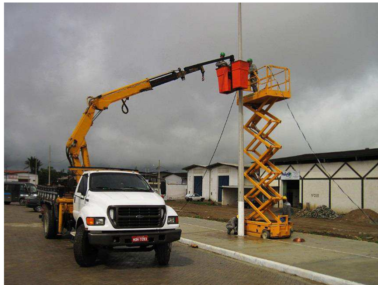
Figura 14 – Fotografia da passagem dos cabos, utilizando uma cesta aérea e uma plataforma elevatória tipo tesoura.
