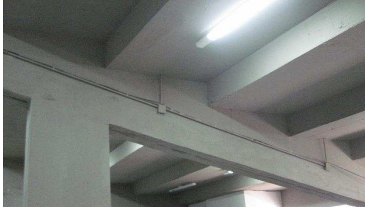
Figura 23 – Fotografia do teto da área interna do estádio.
