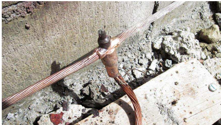
Figura 43 – Fotografia de um ponto de solda da malha de aterramento.
