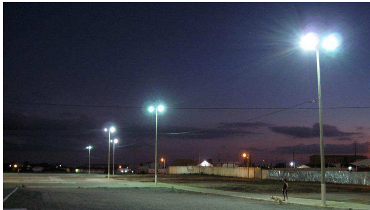
Figura 18 – Fotografia do estacionamento, após a conclusão da instalação da iluminação externa.
