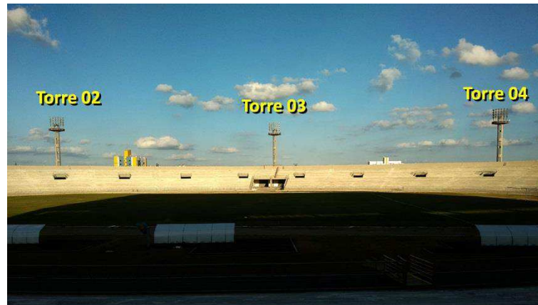
Figura 30 – Fotografia do Estádio O Amigão, na qual podem ser vistas as torres de iluminação 2, 3 e 4.
