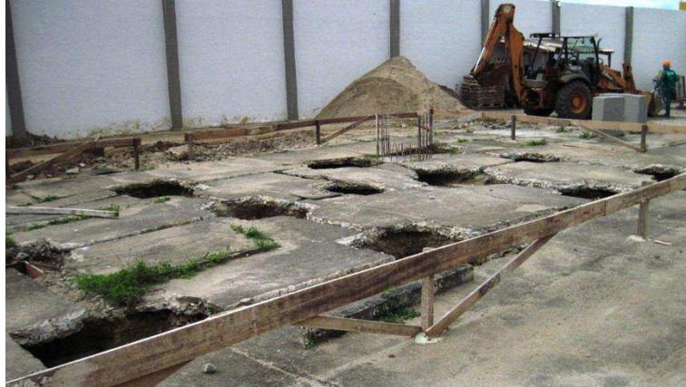
Figura 42 – Fotografia das escavações do alicerce da subestação.
