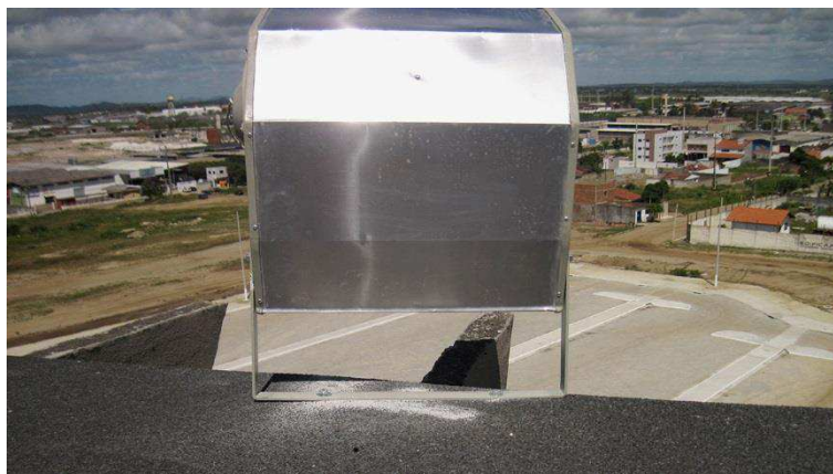
Figura 20 – Fotografia de um refletor de 2000 W fixado no topo da marquise para iluminar o estacionamento.
