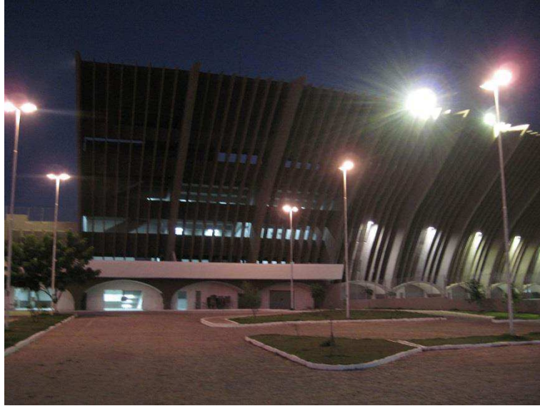
Figura 22 – Fotografia dos postes de iluminação do estacionamento privativo, após a conclusão da manutenção.
