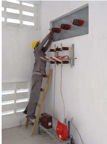
Figura 46 – Fotografia da equipe da Viridis Engenharia instalando as buchas de passagem interno/externo na subestação.
