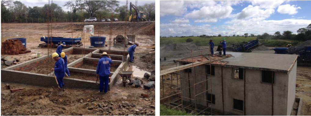
Figura 32 Fase de construção civil da SE.
