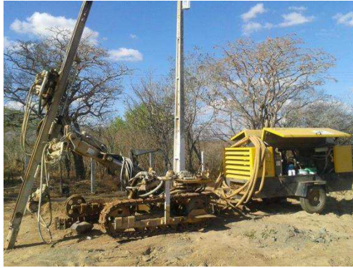
Figura 24 Máquina utilizada para perfuração: Carreta de perfuração PWH-5000; Compressor Atlas Copco XAS 420.
