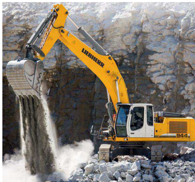
Figura 11 Escavadeira hidráulica modelo R944C [5].
