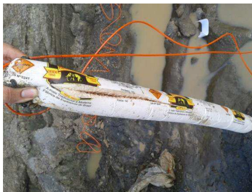
Figura 25 Emulsão encartuchada como carga de fundo.
